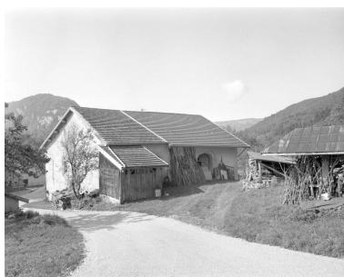
Prévôté, ferme. Phot. Jérôme Mongreville IVR43_19943901097X
