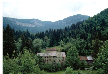
Tournerie Vuillermoz. Phot. Yves Sancey IVR43_19913900808ZA
