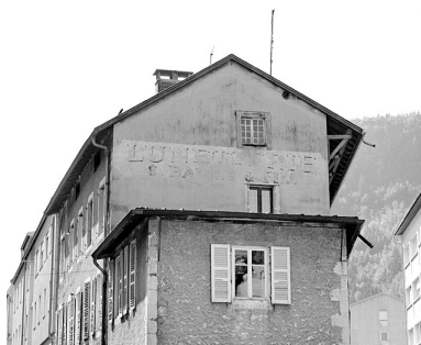
Inscription sur le mur pignon nord. Phot. Yves Sancey IVR43_20033900494X
