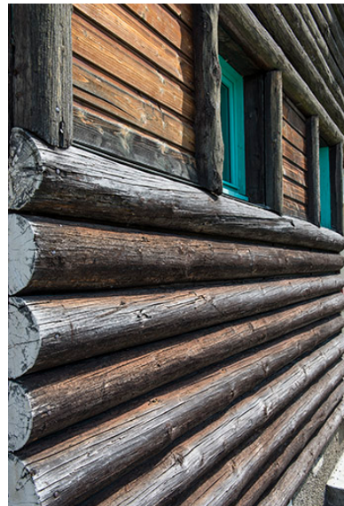
Vue de profil des demi rondins. Phot. Jérôme Mongreville IVR43_20177000668NUC4A
