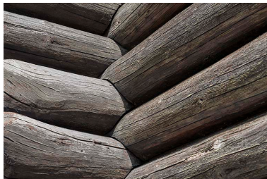
Détail sur l'assemblage. Phot. Jérôme Mongreville IVR43_20177000667NUC4A
