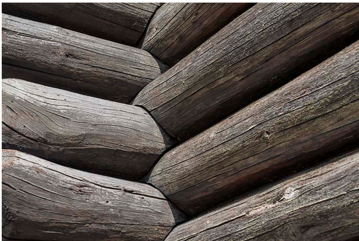
Détail sur l'assemblage.
