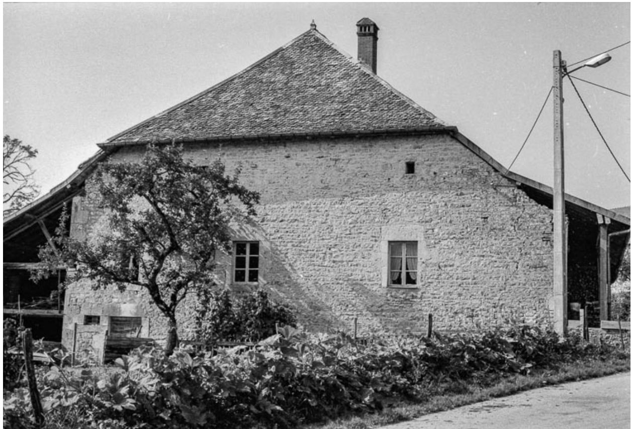
Ferme cadastrée 1961 AC 31 : façade latérale gauche.
