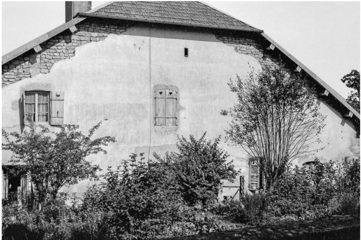
Ferme cadastrée 1961 AC 107 : façade antérieure.
