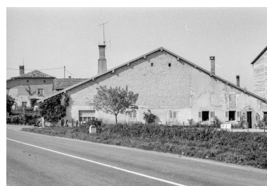
Ferme cadastrée 1961 AB 45 : façade antérieure. Phot. Gilbert Poinot IVR43_19752501380Z
