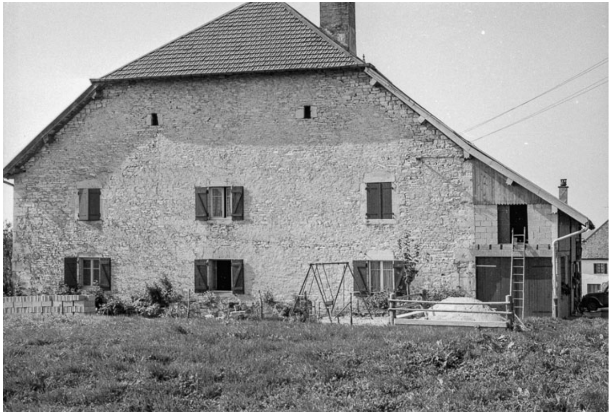
Ferme cadastrée 1961 AB 42 : façade antérieure.
