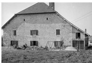
Ferme cadastrée 1961 AB 42 : façade antérieure. Phot. Gilbert Poinot IVR43_19752501382Z
