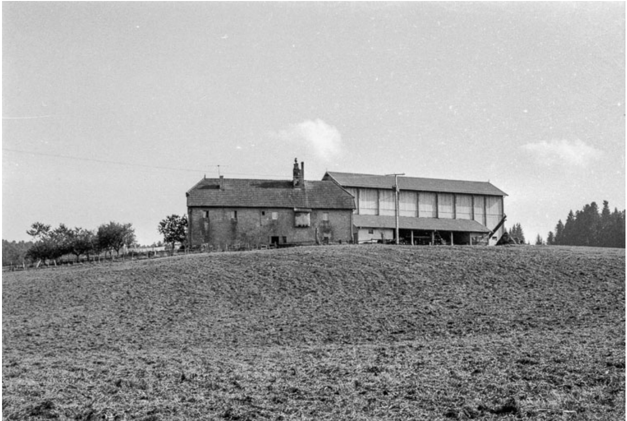
Ferme située au lieudit Loche : vue d'ensemble.
