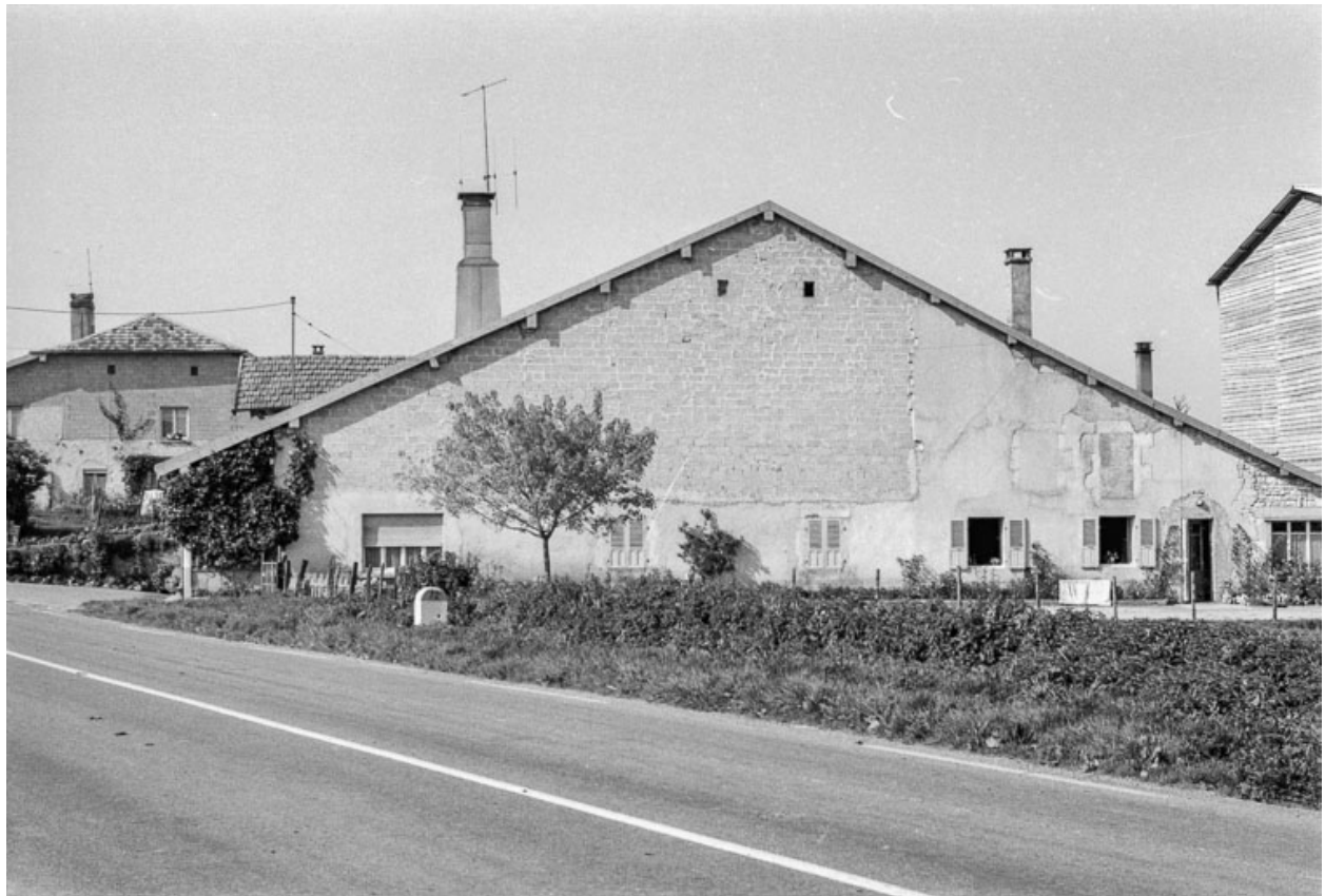
Ferme cadastrée 1961 AB 45 : façade antérieure.
