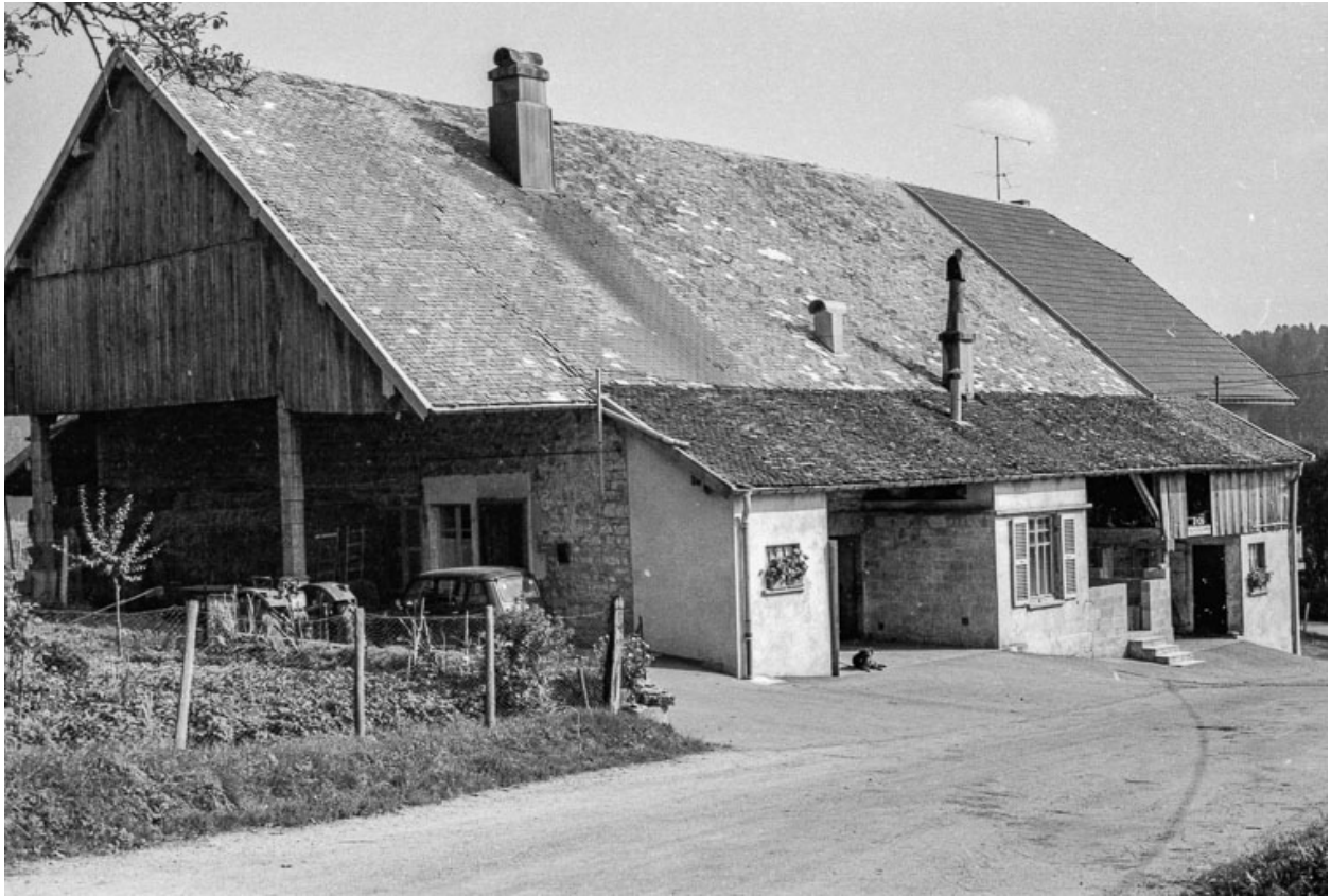
Ferme cadastrée 1961 AC 28 : façade sur rue.
