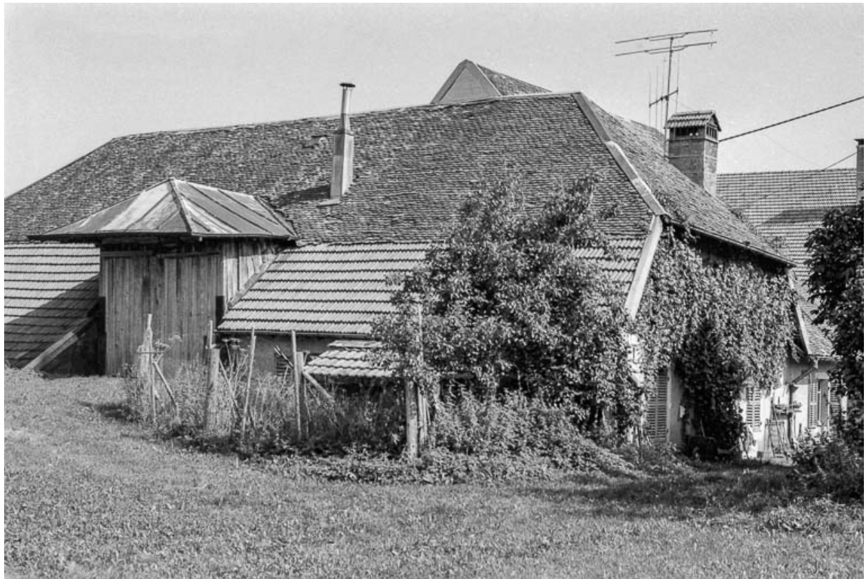
Ferme cadastrée 1961 AB 62 : façade latérale gauche.
