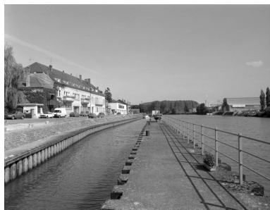
Vue de l'écluse le long du quai Vergy. Phot. Yves Sancey IVR43_19887000065X
