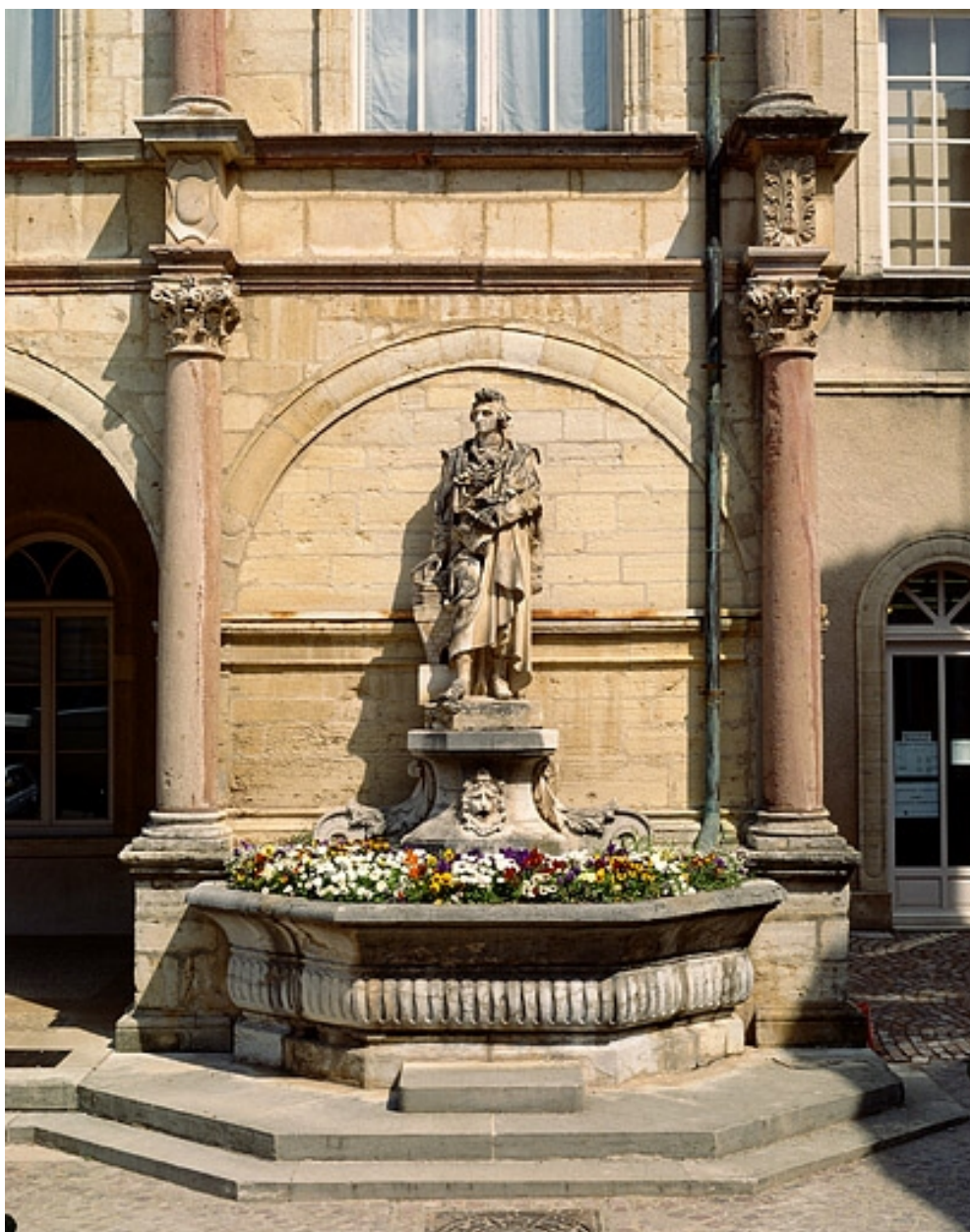
Fontaine de Romé de l'Isle : vue d'ensemble.
