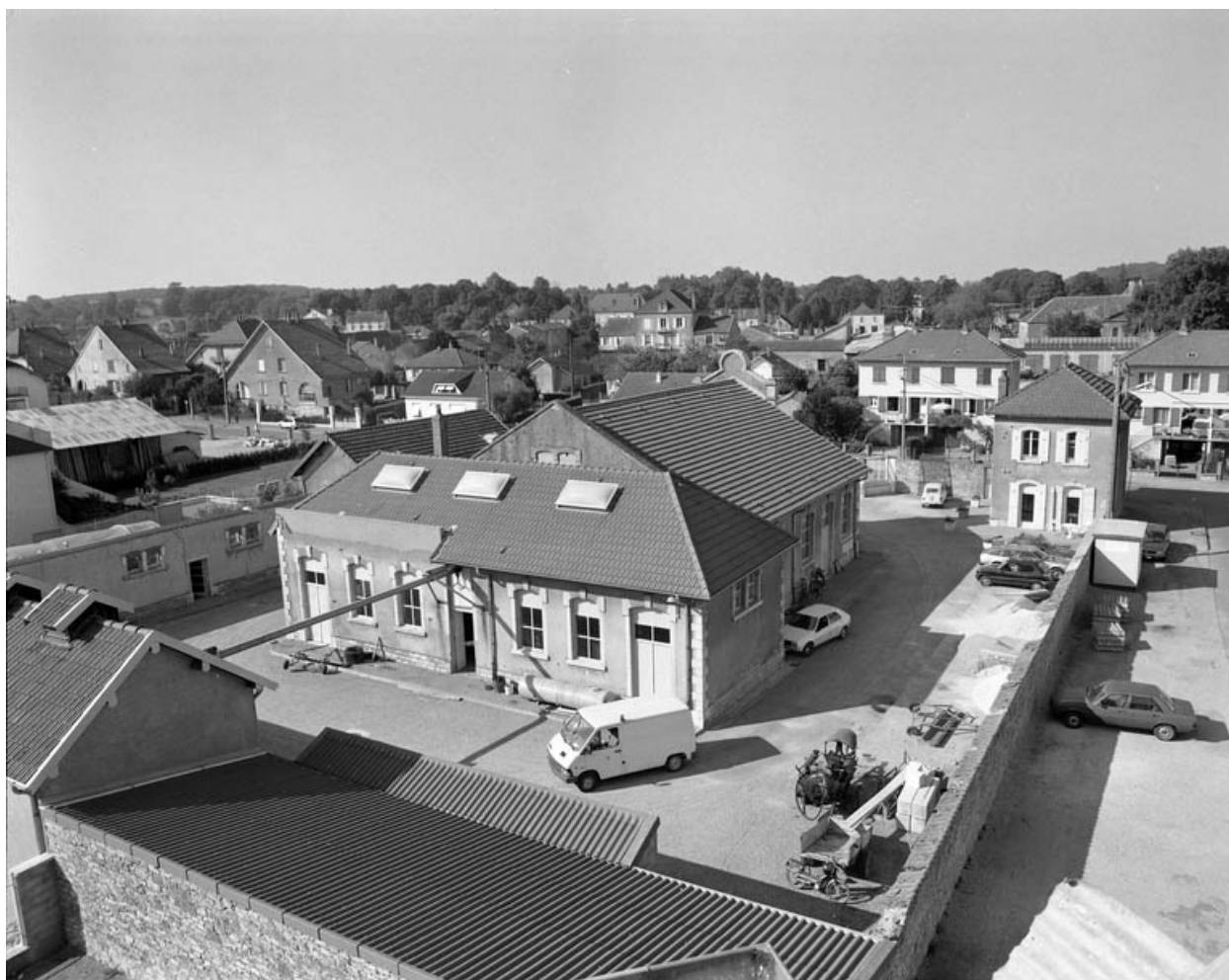
Vue d'ensemble du quartier de l'abattoir.
