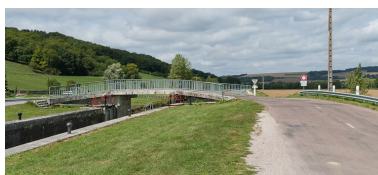
Vue du pont depuis l'amont. Phot. Pierre-Marie Barbe-Richaud
