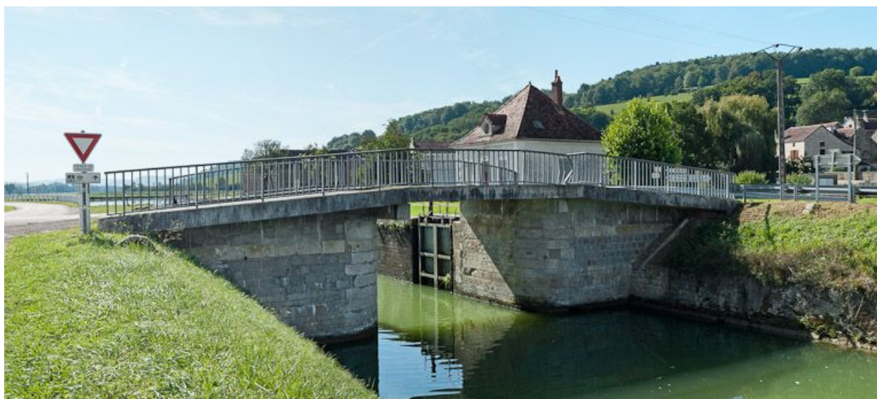
Vue du pont depuis l'aval.
