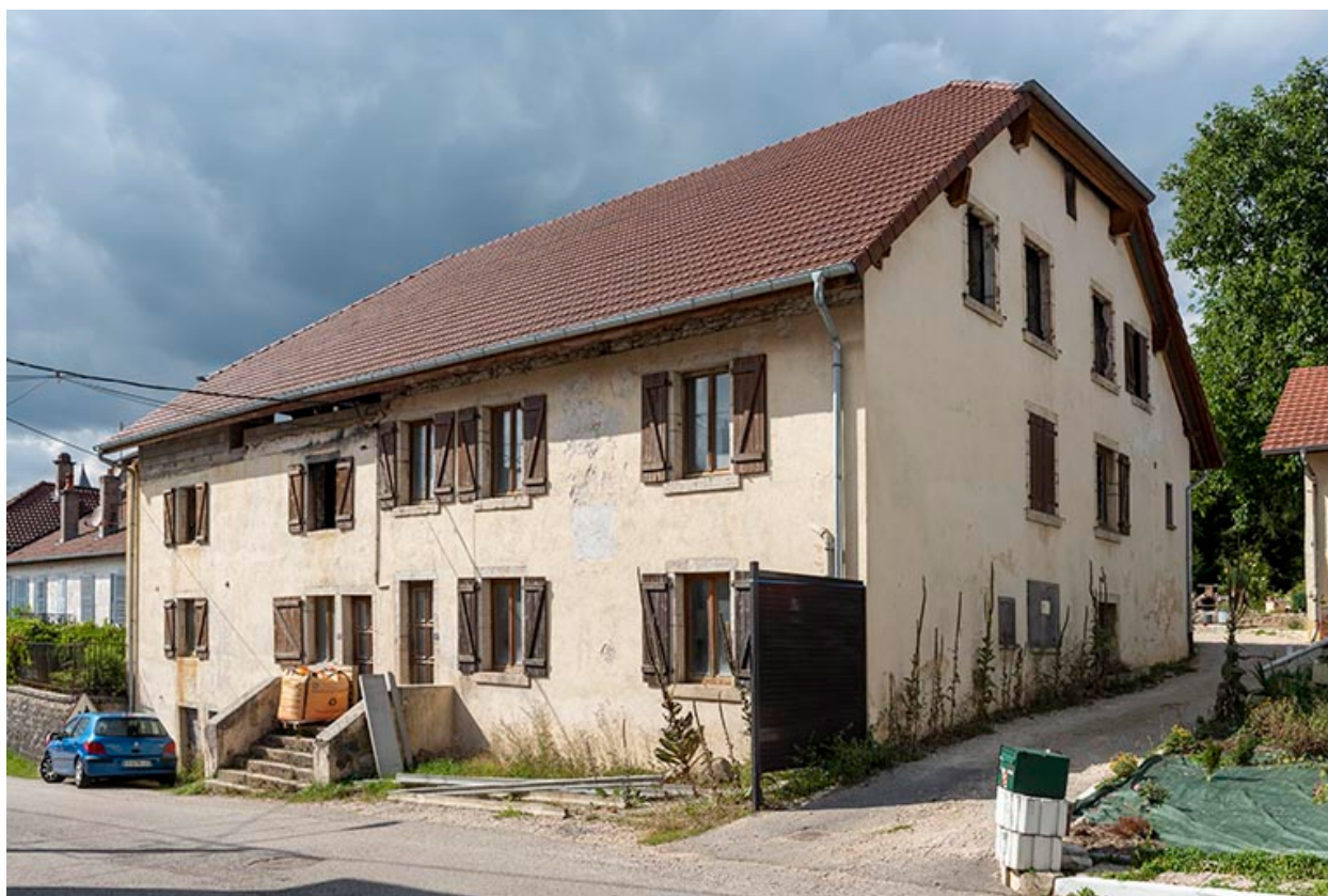
Usine d'outillage Besançon (la "Caserne"), 2-6 Grande Rue.
