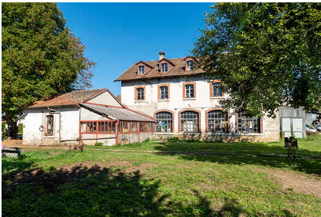
Usine d'outillage (la "Fabrique"), 31-33 rue de Saint-Hippolyte.
