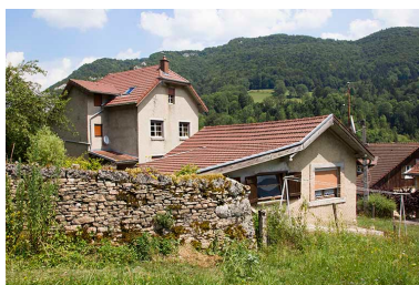
Atelier de fabrication et logement, depuis l'ouest. Phot. Yves Sancey IVR43_20132501417NUC2A
