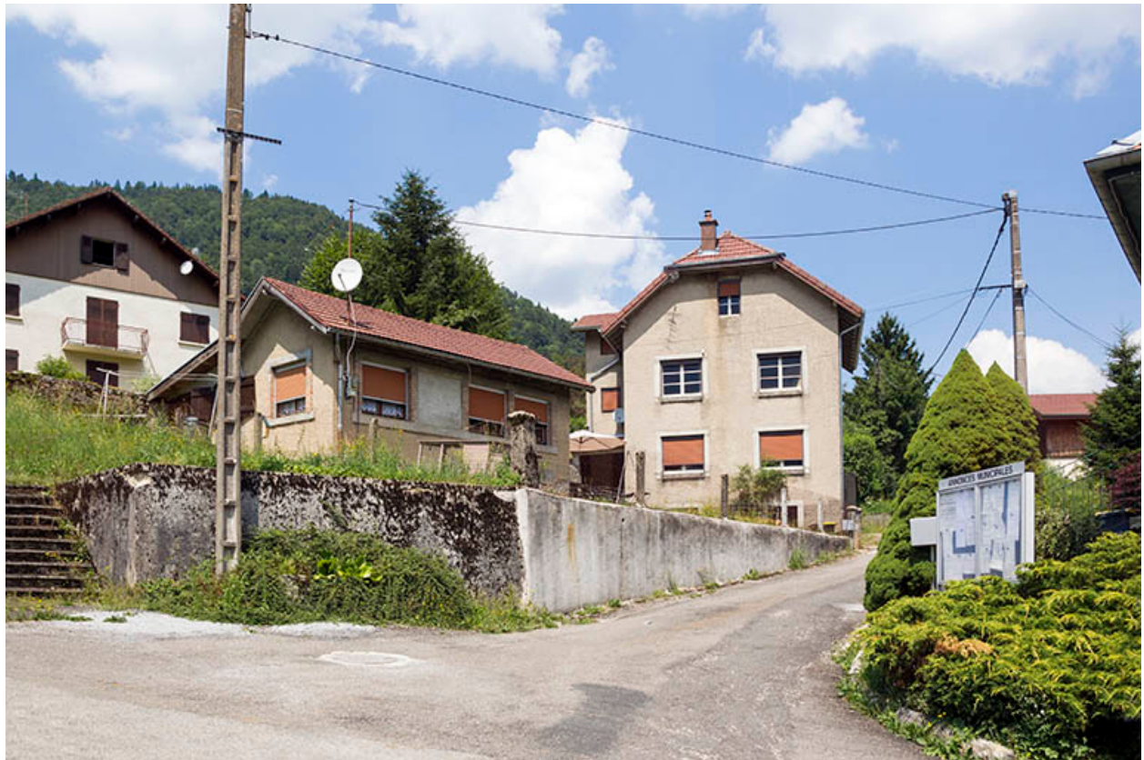
Vue d'ensemble, depuis le sud.
