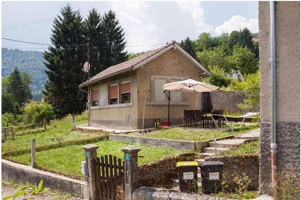
L'atelier de fabrication, depuis le nord-est.
