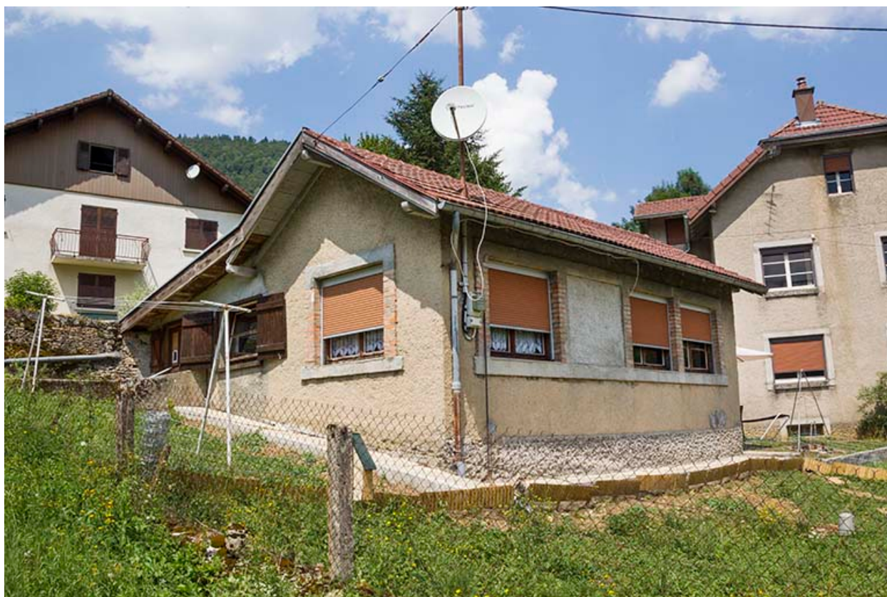
L'atelier de fabrication, depuis le sud.
