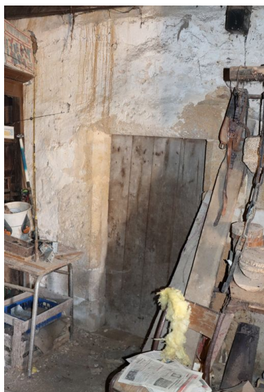
Détail de la porte ouvrant vers l'extension adossée contre le mur pignon sud de la maison. Phot. Baptiste Quost IVR26_20242100019NUC2A
