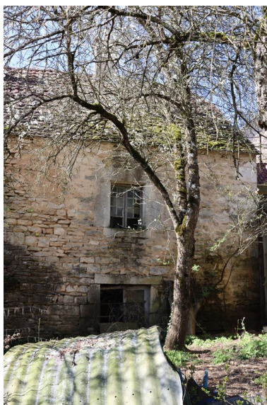
Vue d'une partie de l'élévation Est de la maison, couverte en laves. Phot. Baptiste Quost IVR26_20242100011NUC2A
