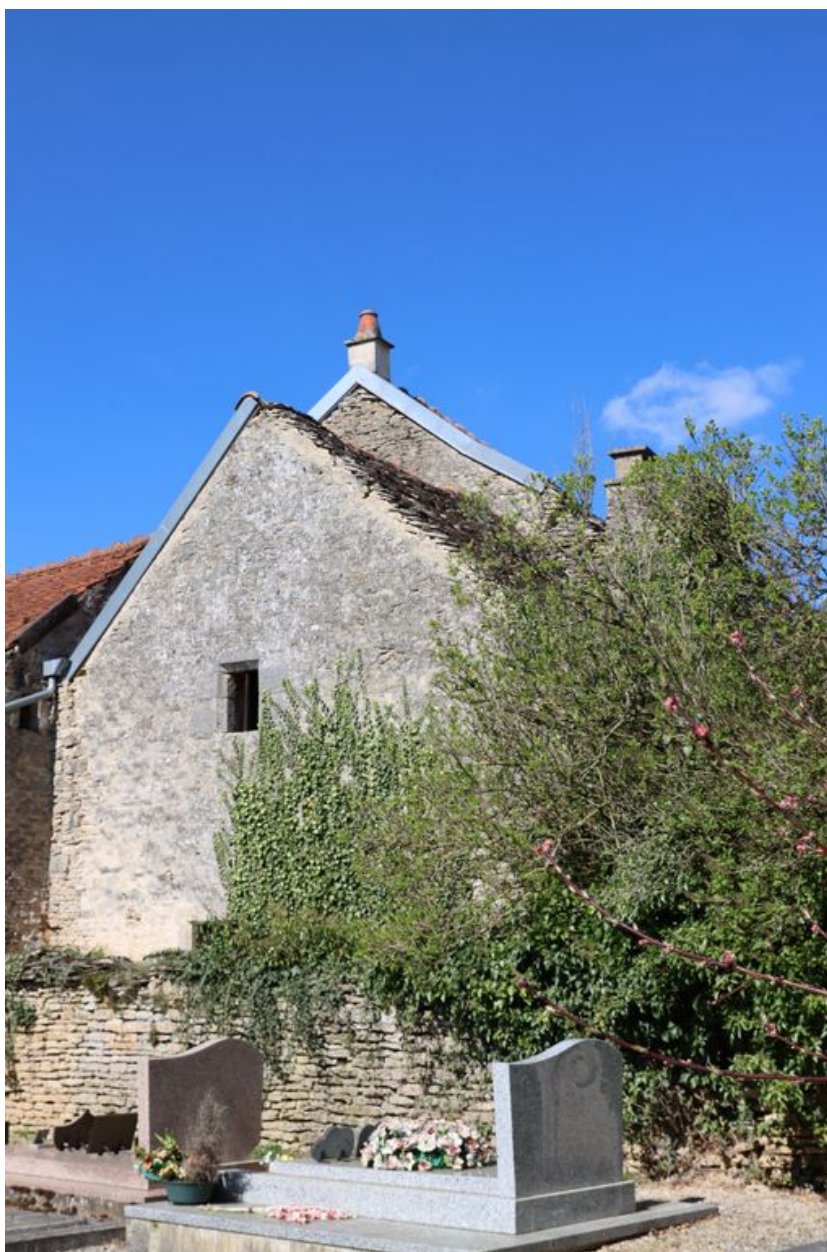
Vue du mur pignon de l'extension Sud.
