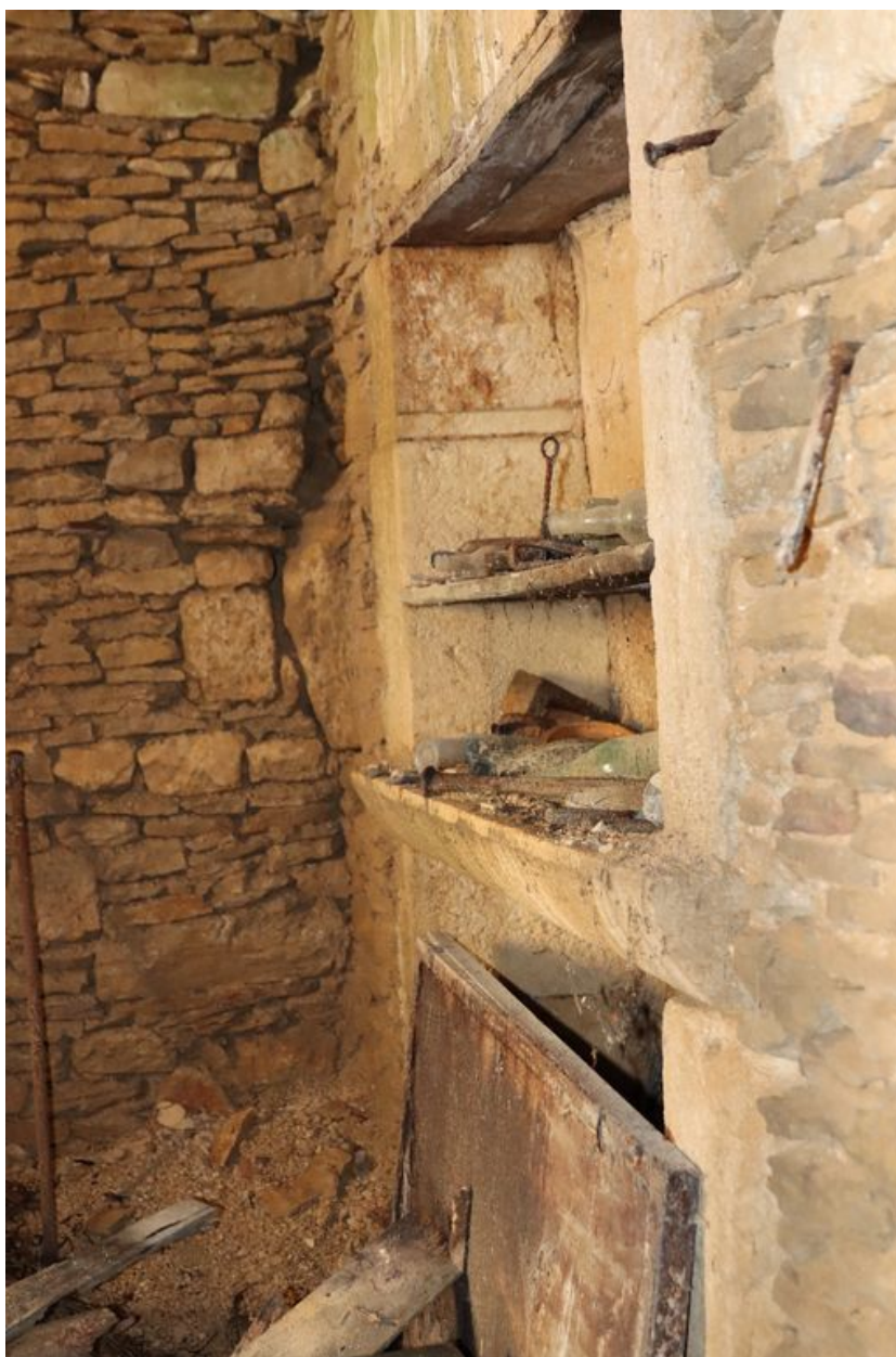
Vue du revers de la cheminée du rez-de-chaussée, dotée de niches murales superposées.
