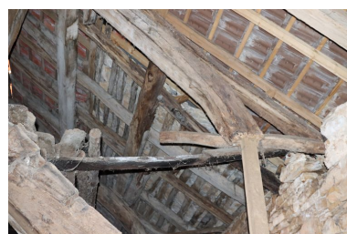
Vue de la sous-face du toit en laves de la maison. Phot. Baptiste Quost IVR26_20242100015NUC2A
