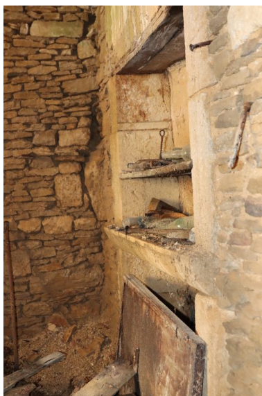
Vue du revers de la cheminée du rez-de-chaussée, dotée de niches murales superposées. Phot. Baptiste Quost IVR26_20242100020NUC2A
