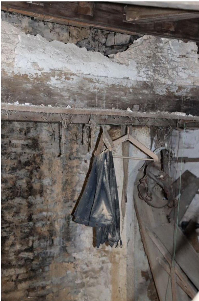
Détail du manteau de la cheminée de l'étage de la maison.
