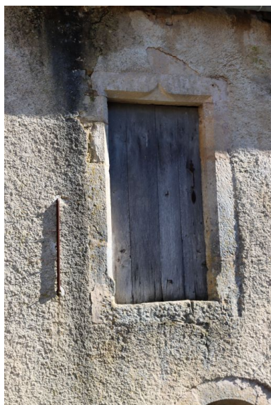
Vue de la porte de l'étage de l'élévation Ouest, couverte d'un linteau en accolade. Phot. Baptiste Quost IVR26_20242100009NUC2A
