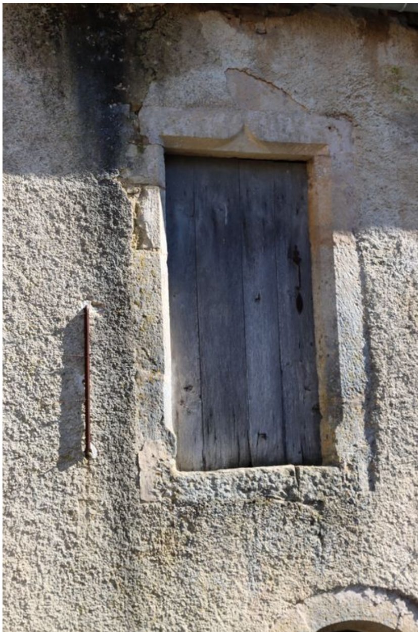
Vue de la porte de l'étage de l'élévation Ouest, couverte d'un linteau en accolade.
