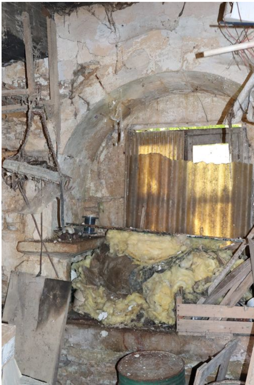
Vue de la niche (placard et évier) aménagée dans le mur gouttereau Est.
