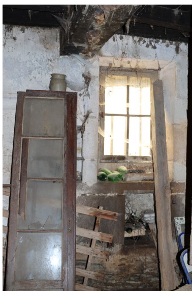
Détail de la baie percée dans le mur sud de l'extension, environnée de placards muraux.
