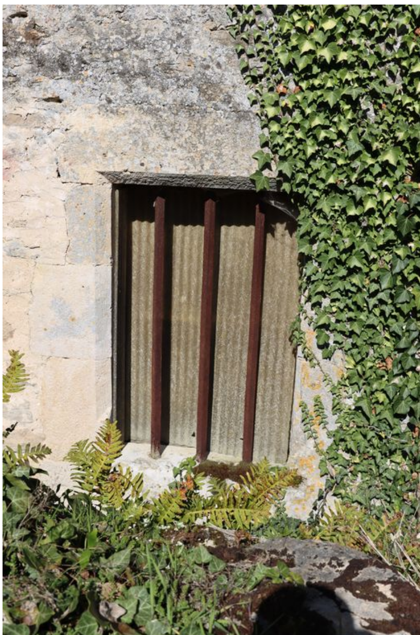
Détail d'une fenêtre de l'extension sud.
