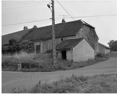
Façade postérieure. Phot. Yves Sancey IVR43_19843900166X
