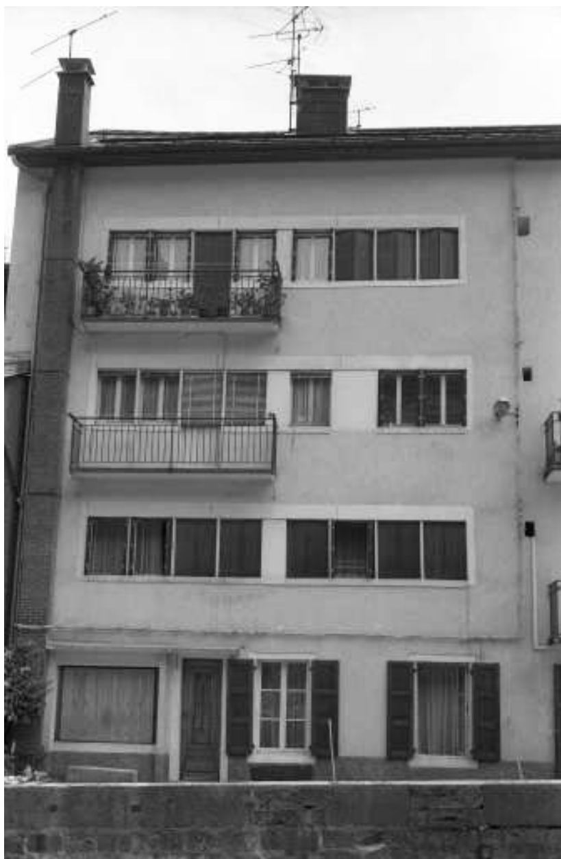
Détail de la façade latérale gauche.
