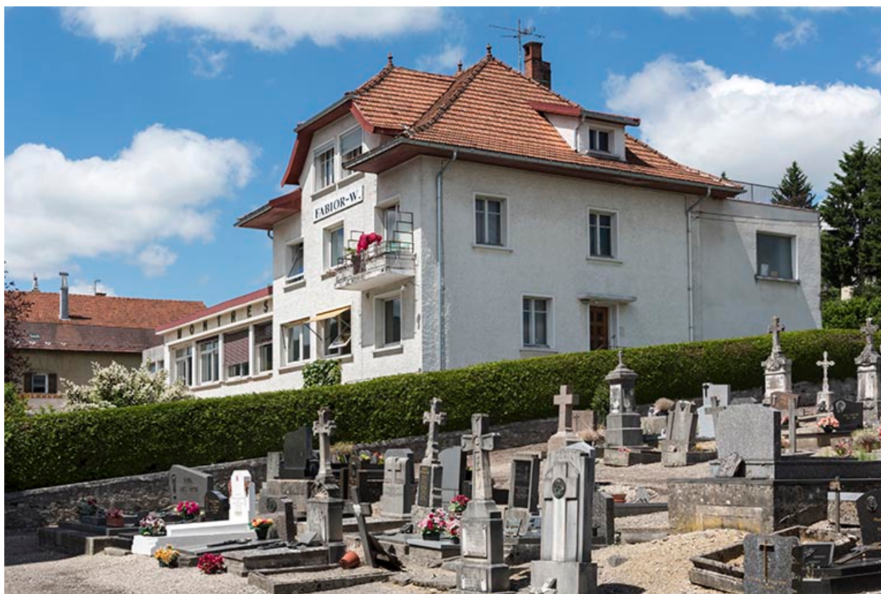
Façades antérieure et latérale droite.
