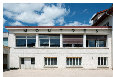
Façade antérieure de l'usine. Phot. Sonia Dourlot IVR43_20162501690NUC4A
