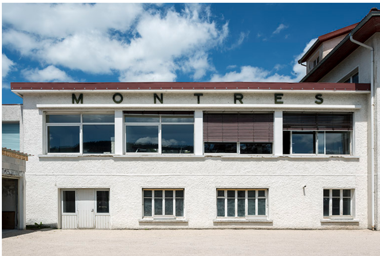
Façade antérieure de l'usine.
