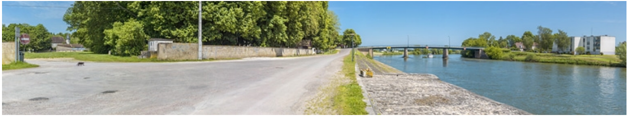
Vue d'ensemble des quais à gradins.
