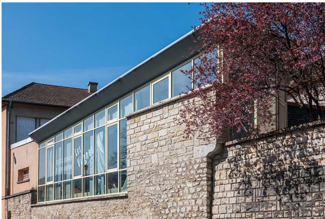
Restaurant d'application : façade sur avenue Delort
