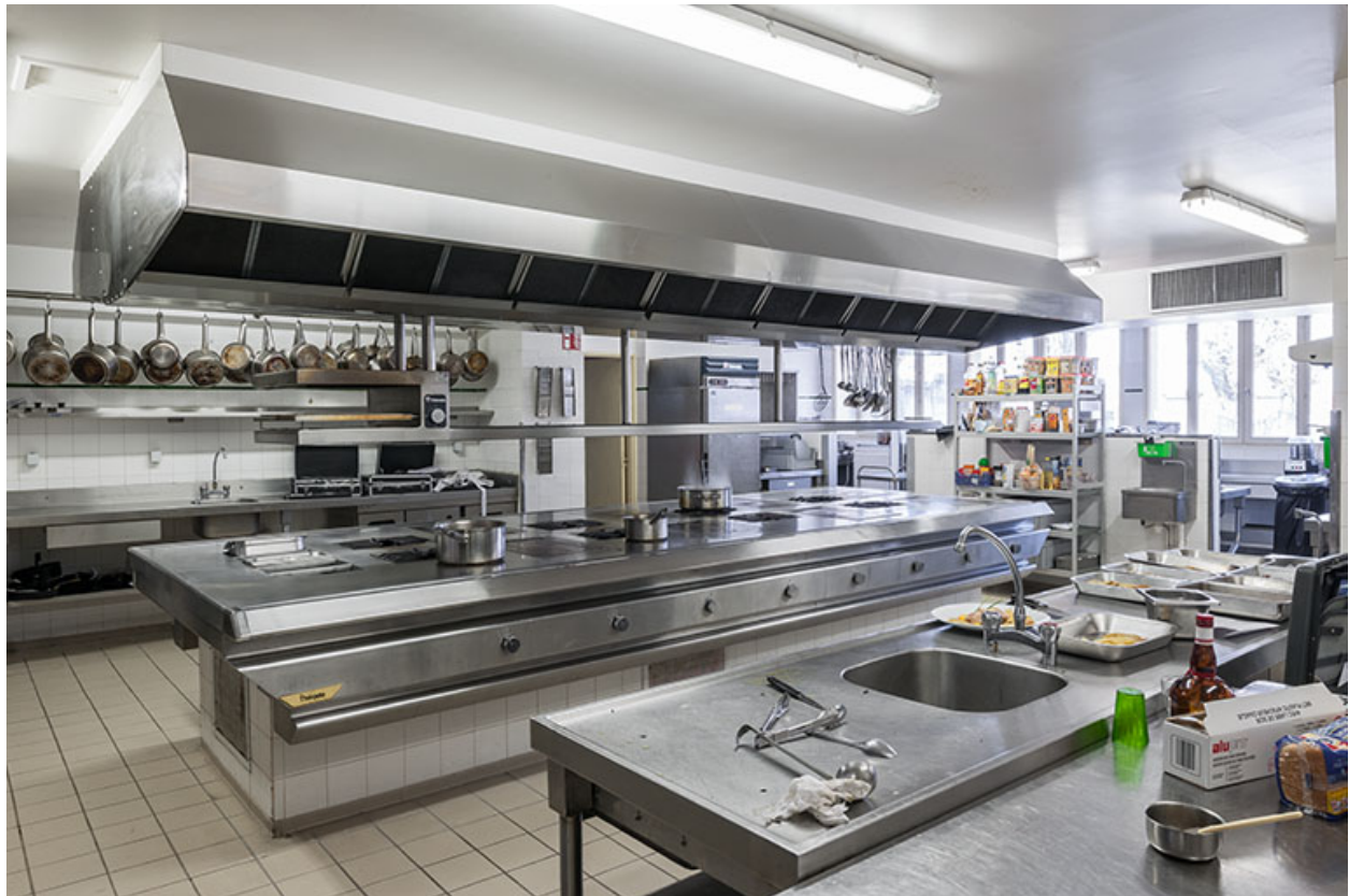
Restaurant d'application : les cuisines.
