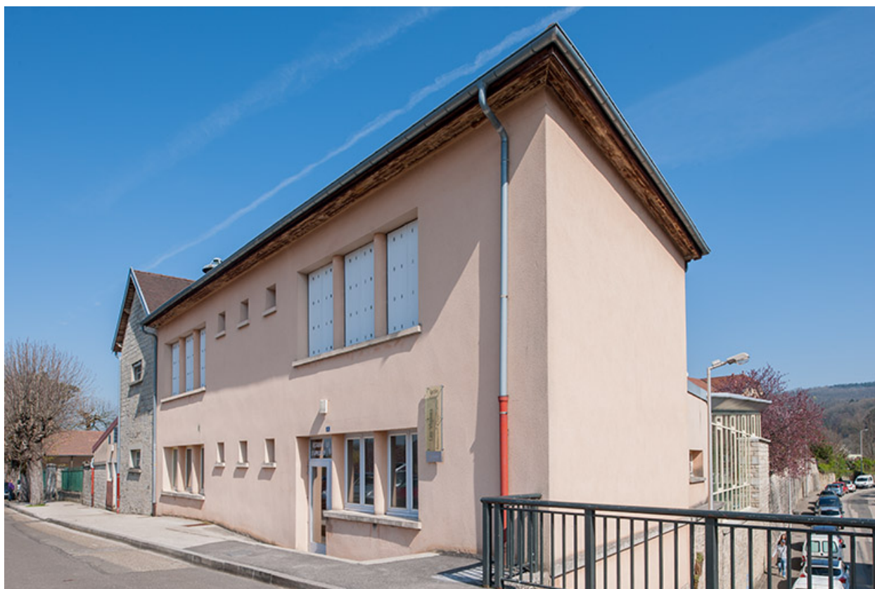
Annexe : façade antérieure, rue des écoles.
