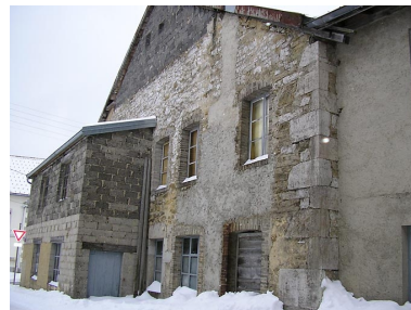
Façade nord-est et appentis. Phot. Marie-Pierre Reynet IVR43_20083900498NUC1A
