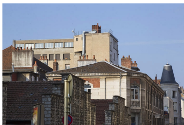
Façade postérieure : vue éloignée.
