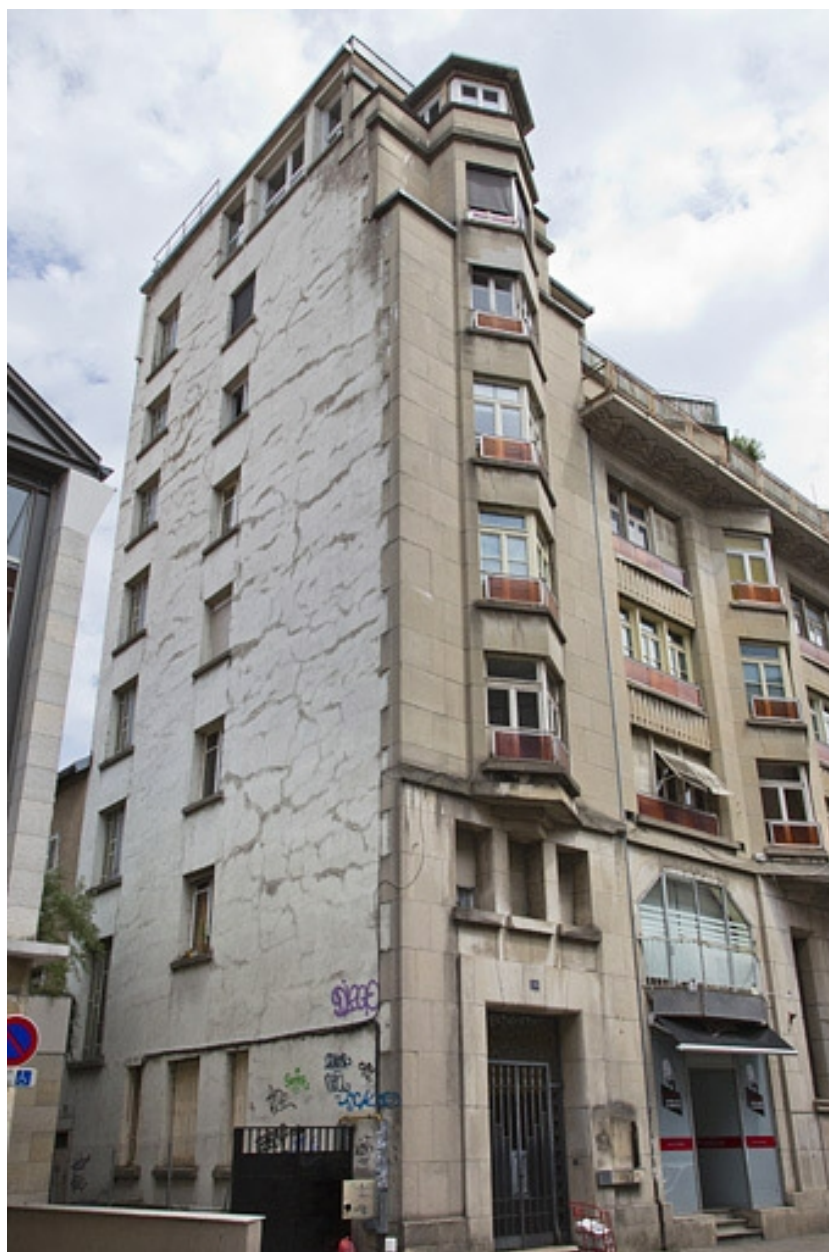
Façade latérale gauche : de trois quarts gauche.
