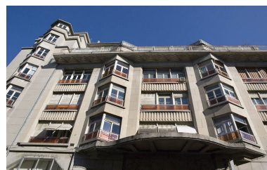
Façade : auvent et balcons. Phot. Yves Sancey IVR43_20062500624NUCA
