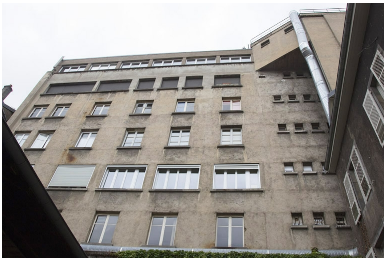
Façade postérieure : vue rapprochée.
