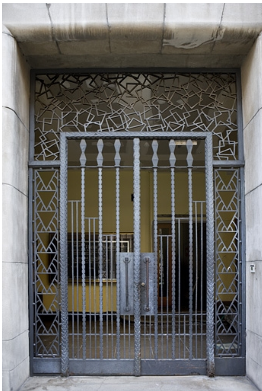
Portail d'entrée : détail de la grille.
