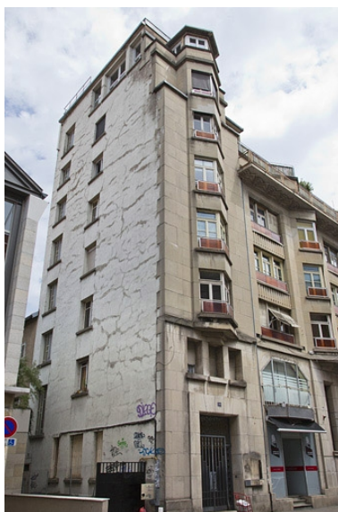
Façade latérale gauche : de trois quarts gauche. Phot. Yves Sancey IVR43_20112501746NUC2A
