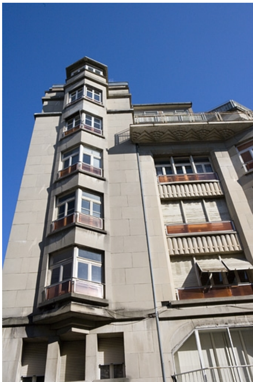
Façade antérieure : détail de la partie gauche.
