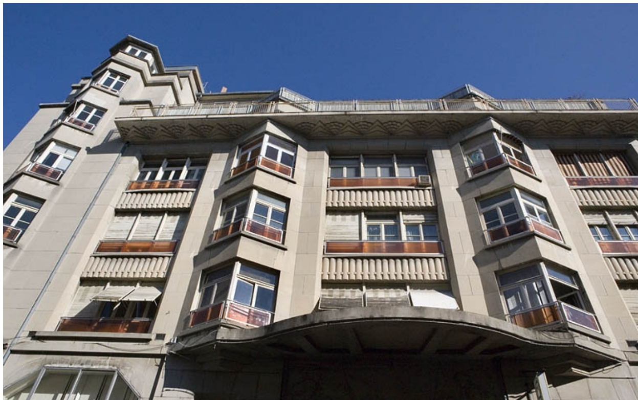
Façade : auvent et balcons.
