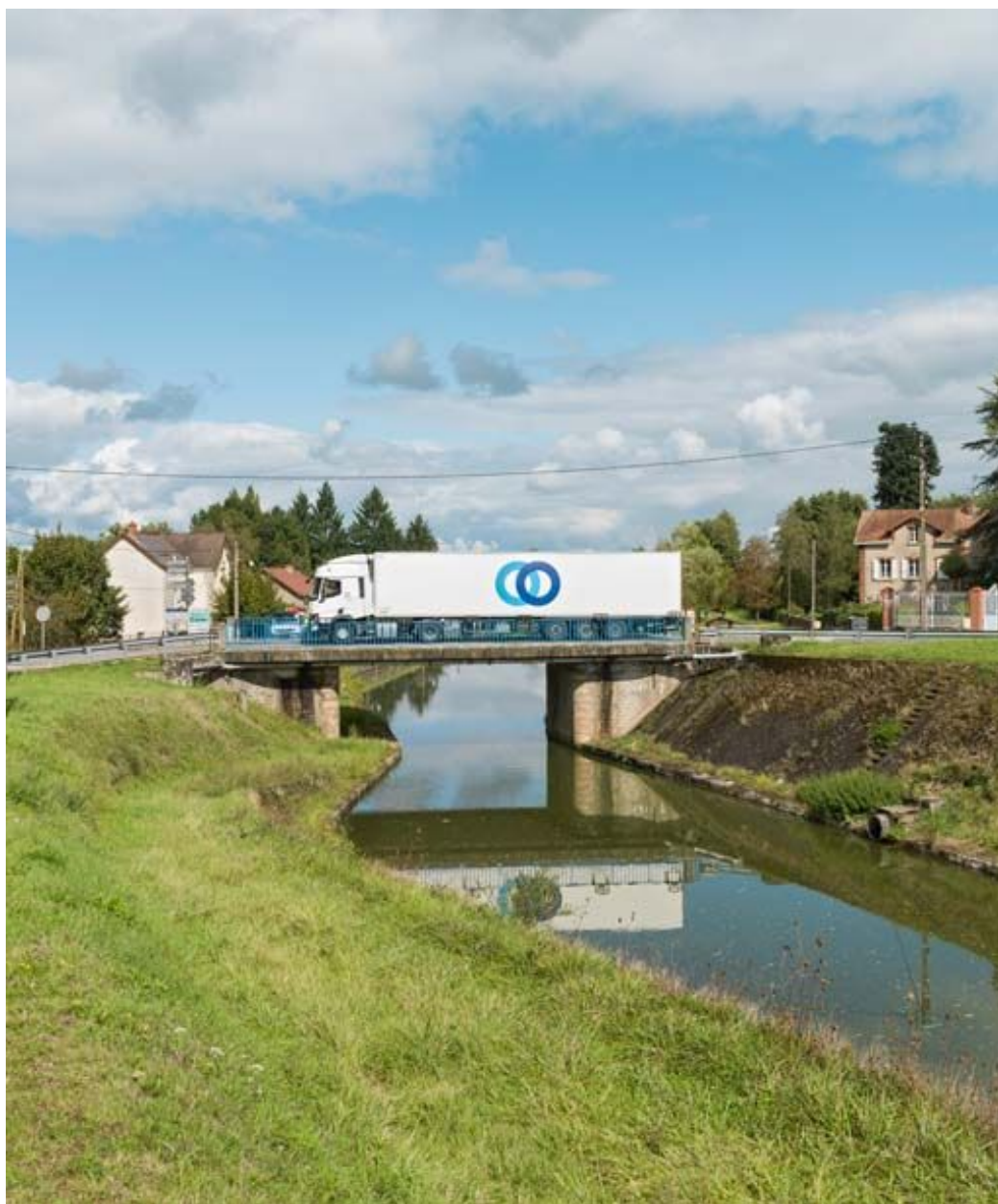
Vue d'ensemble du pont.
