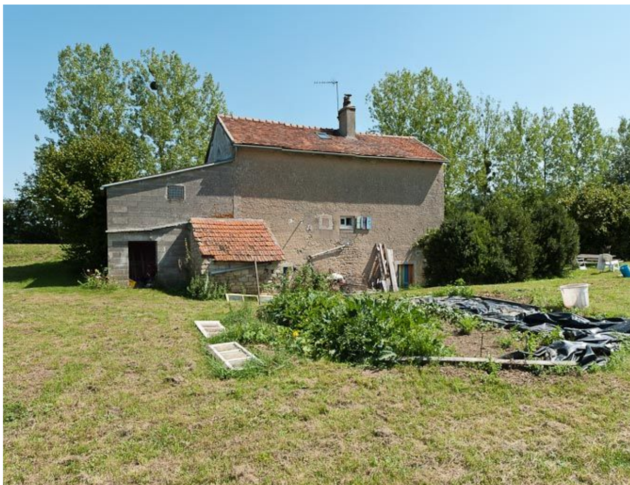
Vue arrière de la maison éclusière.
