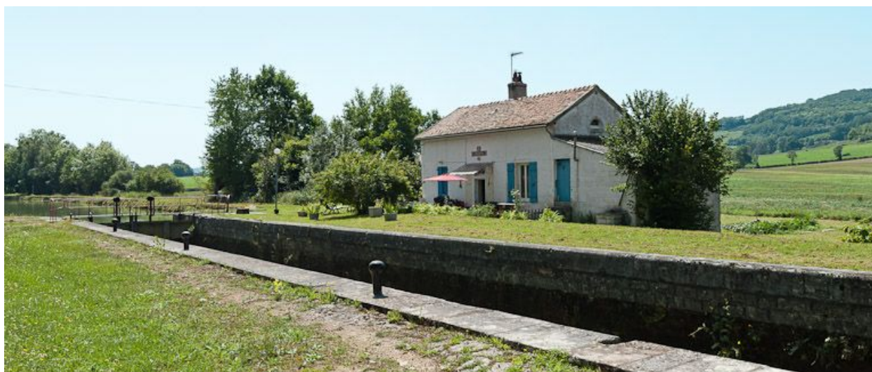
Vue d'ensemble du site d'écluse.
