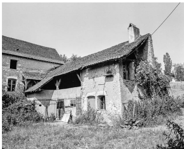
Façade antérieure et aile droite. Phot. Dominique Humbert IVR43_19767000491X
