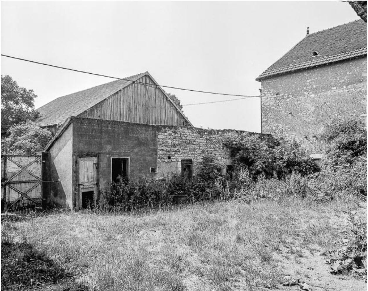
Dépendances à gauche, le long de la rue.
