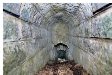
Voûte appareillée en rouleaux à ressauts, depuis l'amont. Phot. Yves Sancey IVR43_20050100030ZA
