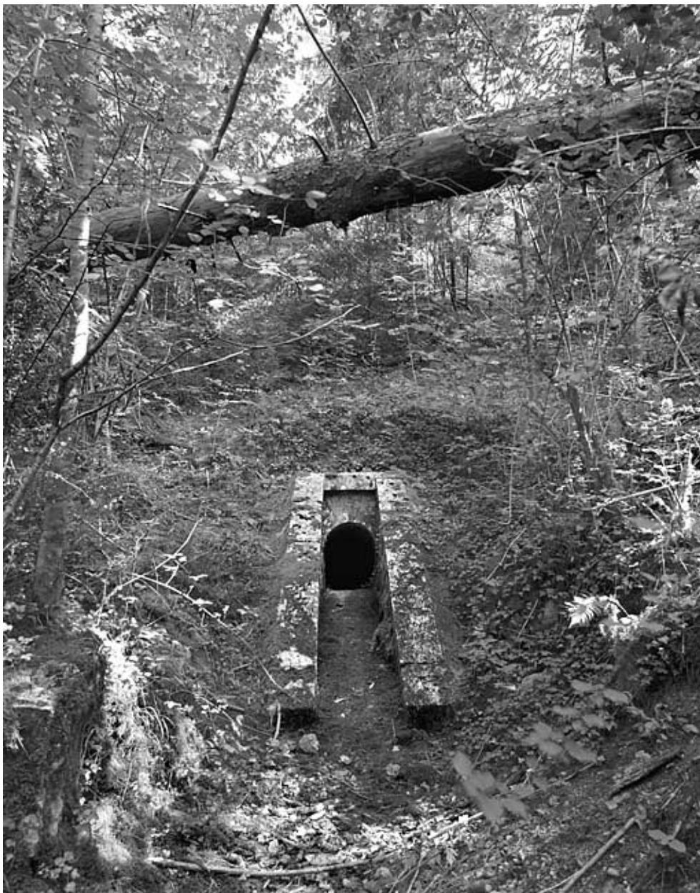
Vue d'ensemble de la tête aval (ouest).
