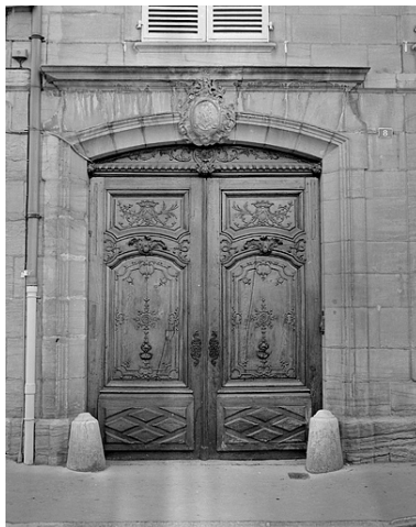
Portail de la façade antérieure. Phot. Yves Sancey IVR43_19833900213X
