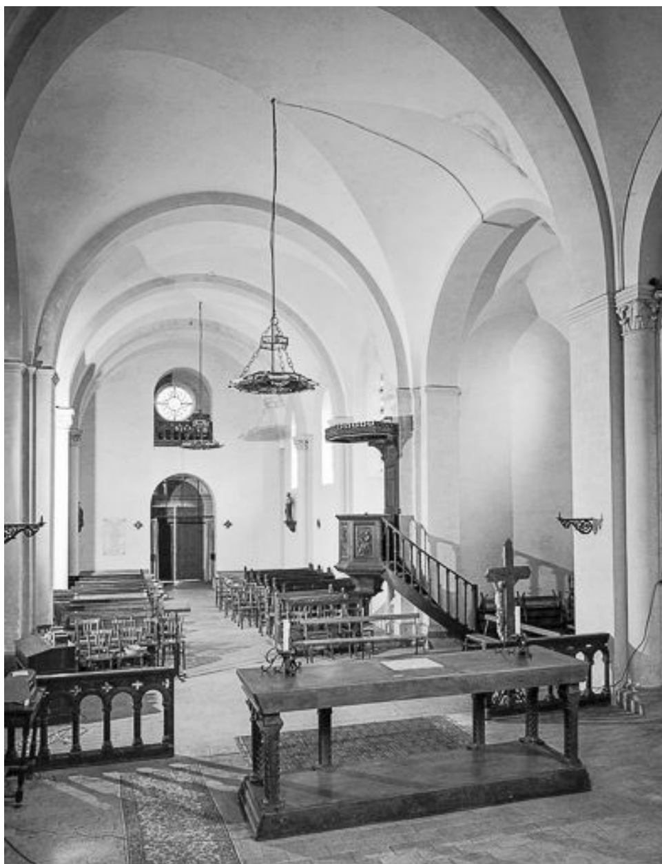
Nef vue depuis le chœur.
