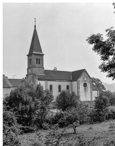
Façade droite. Phot. Yves Sancey IVR43_19843900262X
