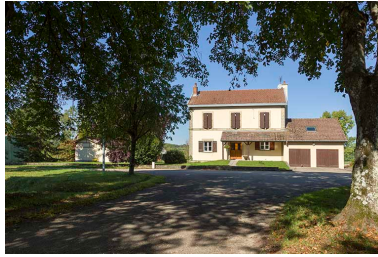
Façade sud-est de l'ancienne gare.
