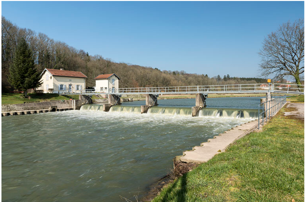
Le site du barrage, vue d'ensemble.
