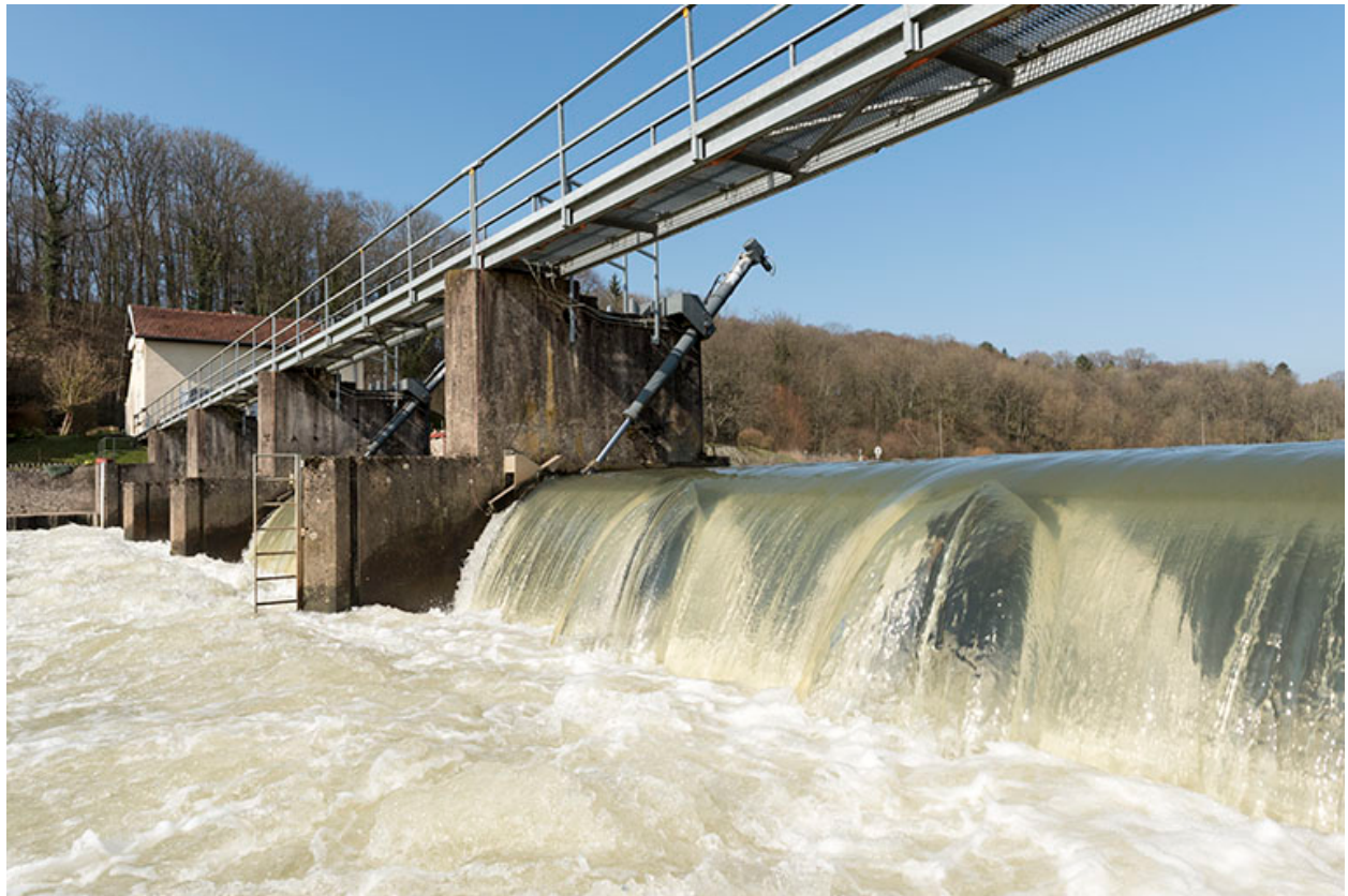
La passerelle du barrage.
