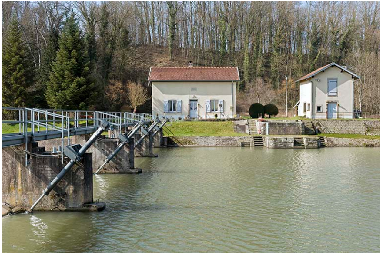
Le barrage et la maison du barragiste.
