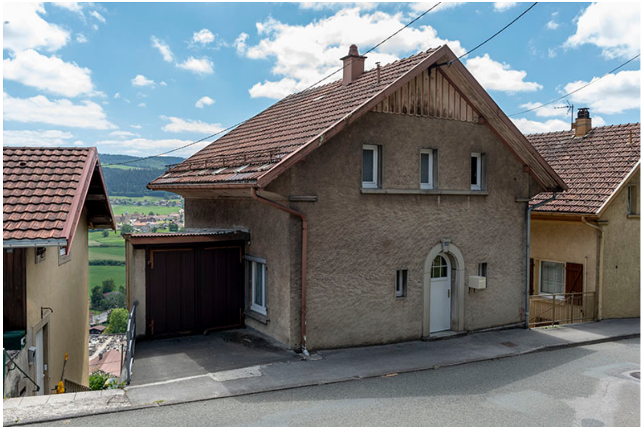
Façades antérieure et latérale gauche.
