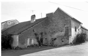
Maison située à Virey. Phot. Bernard Lardière IVR43_19797000336Z
