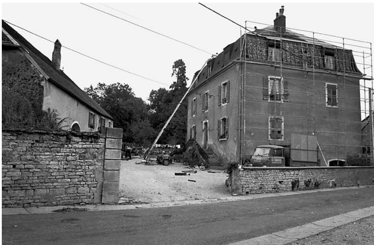
Maison située rue de l'Eglise.
