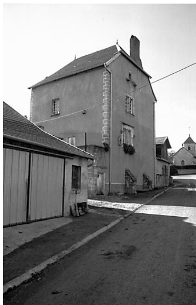
Maison située à Virey. Phot. Bernard Lardière IVR43_19797000337Z
