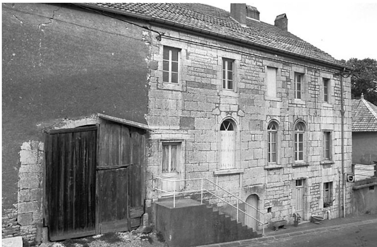
Maison située rue de l'Eglise.
