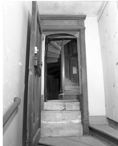
Porte d'entrée ouverte montrant l'escalier en vis contenu dans le cylindre pivotant. Phot. Yves Sancey IVR43_19917000190X
