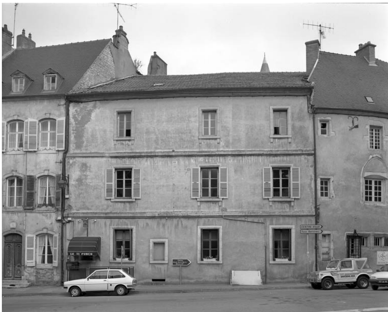
Bâtiment central : façade antérieure, de face.
