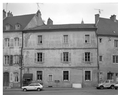
Bâtiment central : façade antérieure, de face.
