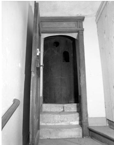
Porte d'entrée ouverte montrant le cylindre pivotant fermé contenant l'escalier. Phot. Yves Sancey IVR43_19917000189X
