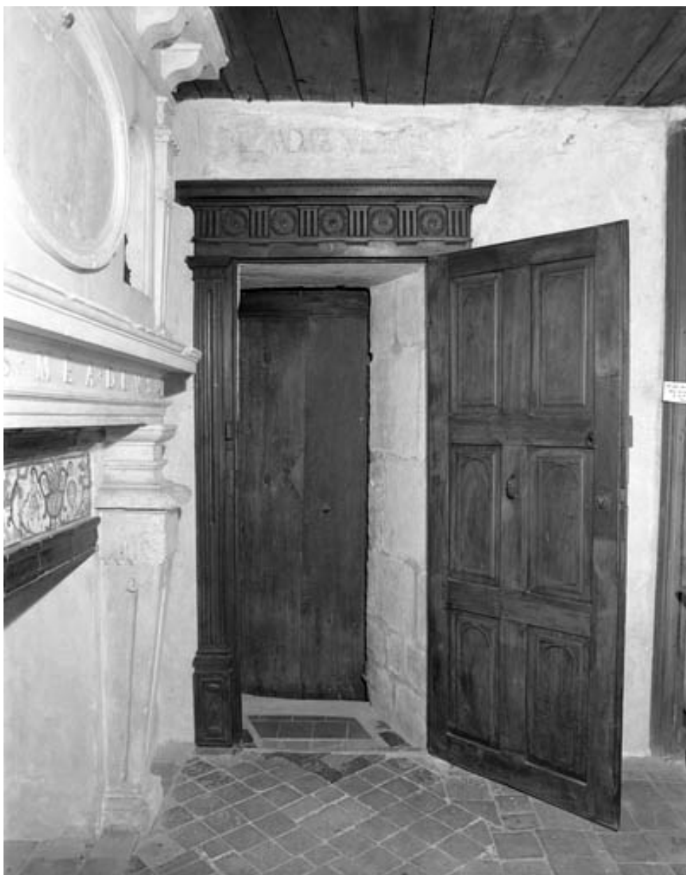
Cellule de saint Pierre Fourier, porte ouverte avec cylindre pivotant présentant sa face pleine.
