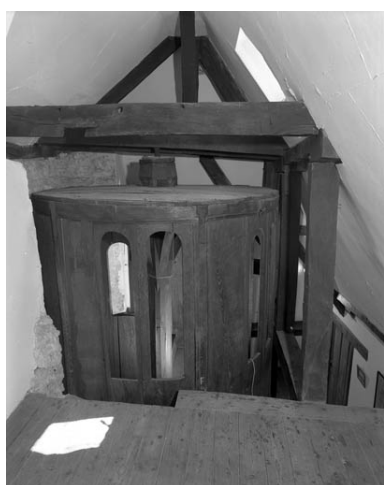
Sommet du cylindre depuis les combles.
