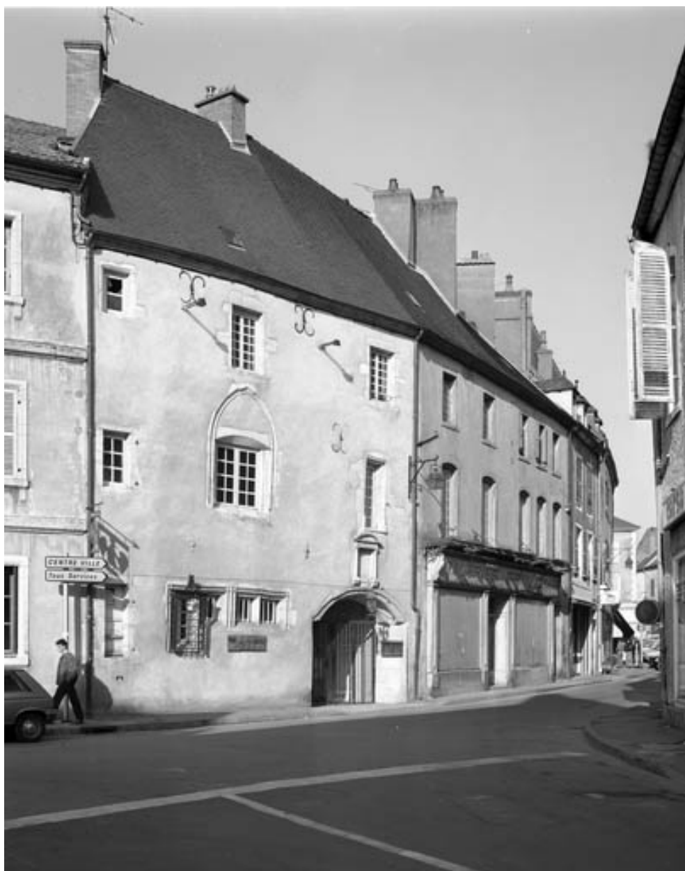
Façade antérieure : partie droite, vue rapprochée.
