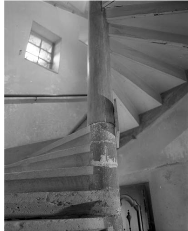
Tour Saint Pierre Fourier : détail de l'escalier en vis, en pierre puis en bois donnant accès à l'escalier pivotant. Phot. Yves Sancey IVR43_19917000187X
