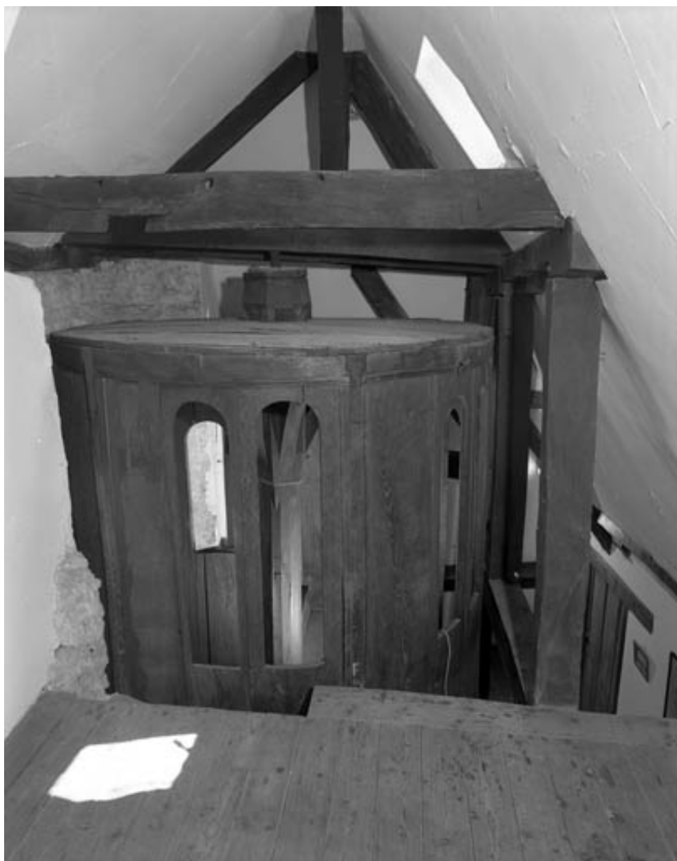
Sommet du cylindre depuis les combles.
