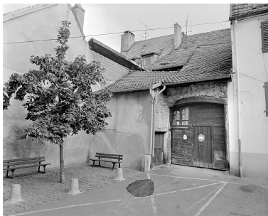
Façade sur l'impasse du Laquet. Phot. Jérôme Mongreville IVR43_19872500476X
