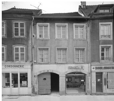
Façade sur la rue de Belfort. Phot. Jérôme Mongreville IVR43_19872501086V
