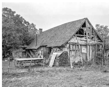
Ferme située chemin des Golards : façade antérieure et face droite. Phot. Yves Sancey IVR43_19843900027X
