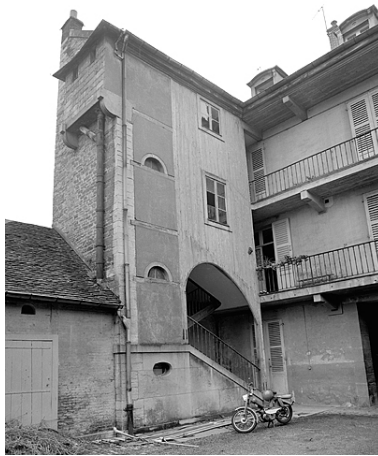
Escalier dans la cour. Phot. Yves Sancey IVR43_19833900242X
