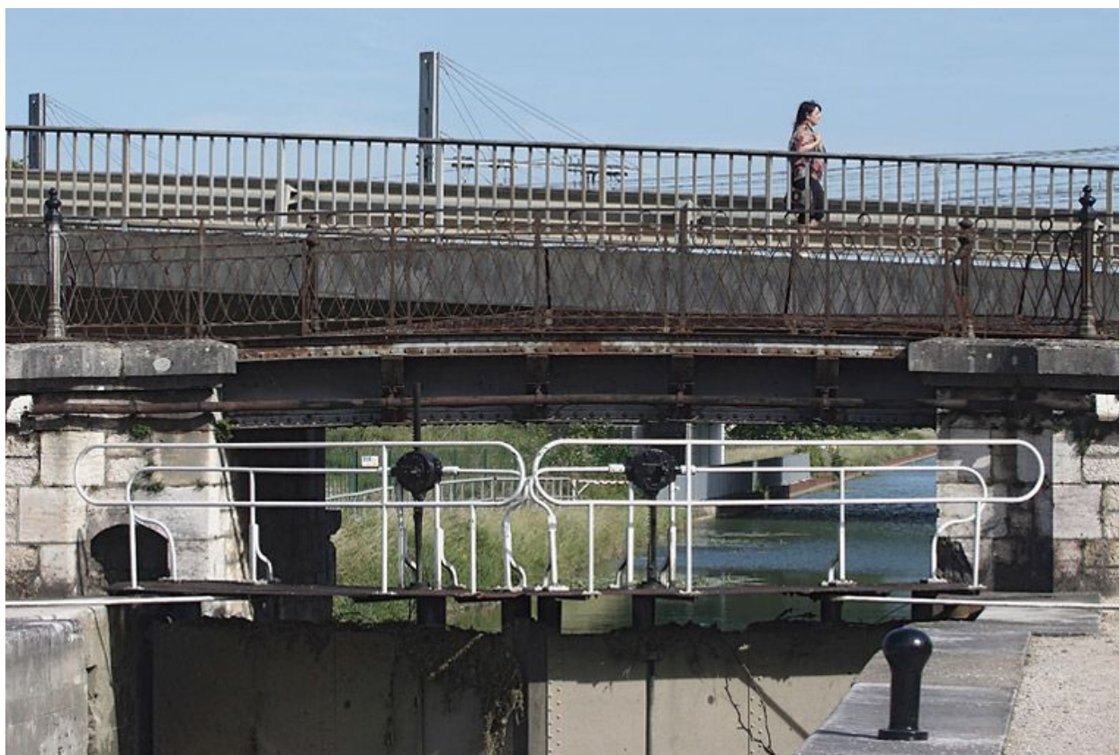
Détail des portes et du pont.
