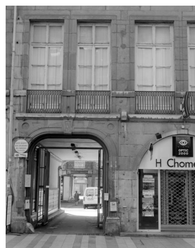
Façade sur rue, détail de l'entrée cochère.
