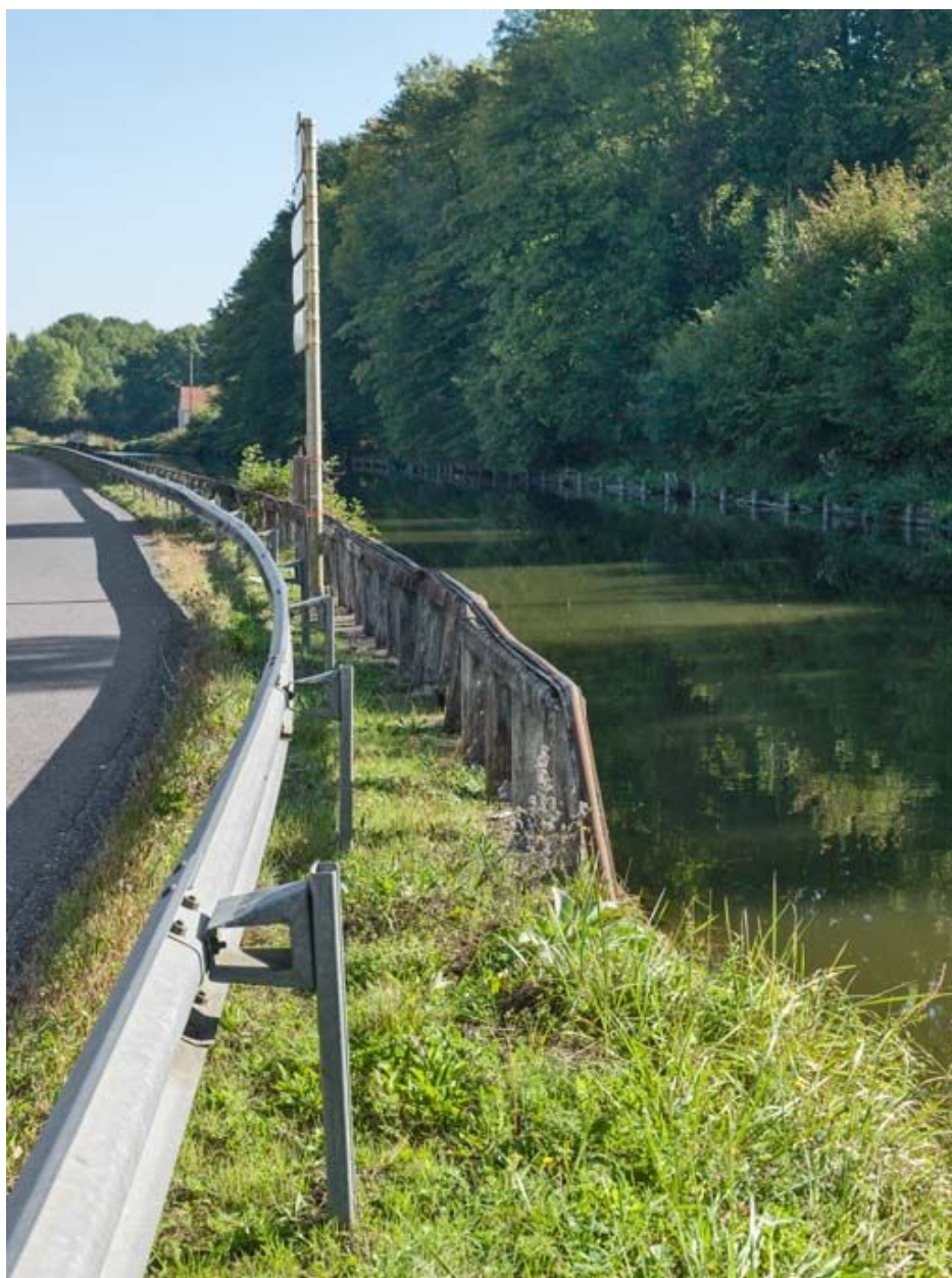
Vue du garde-corps métallique ancien.
