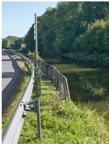
Vue du garde-corps métallique ancien.
