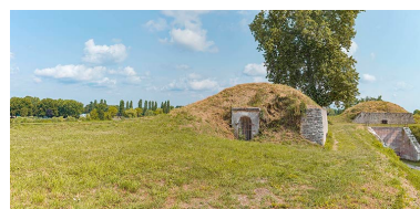
Entrée d'une des casemates sur le terre-plein.
