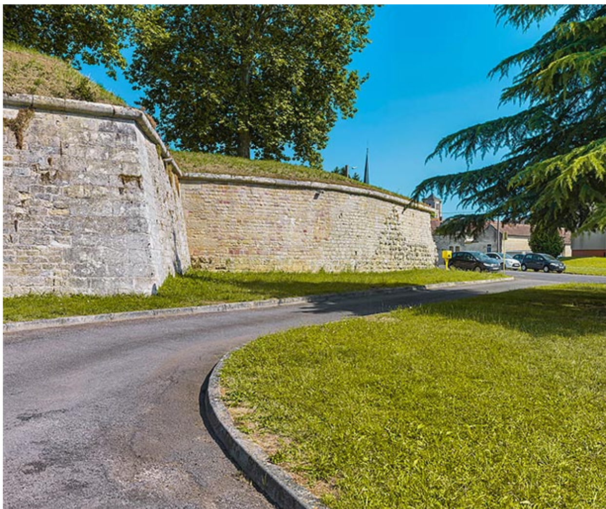
La courtine et l'ancienne tour du "Béchet".
