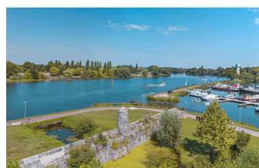
Vue prise depuis le terre-plein du bastion.
