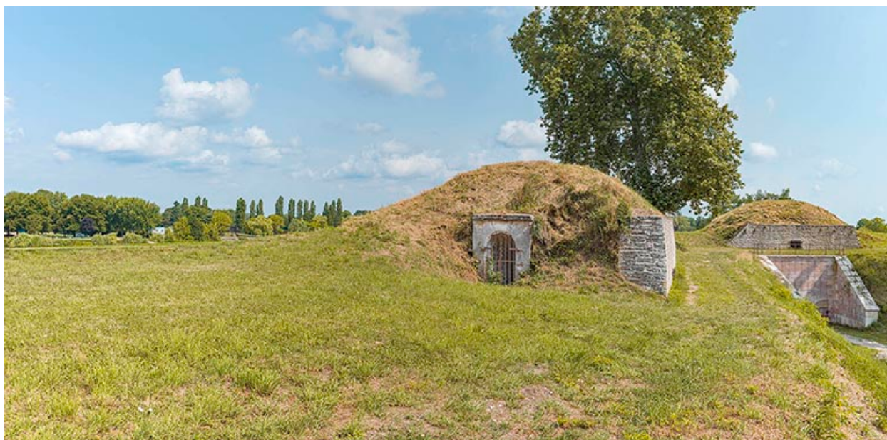
Entrée d'une des casemates sur le terre-plein.
