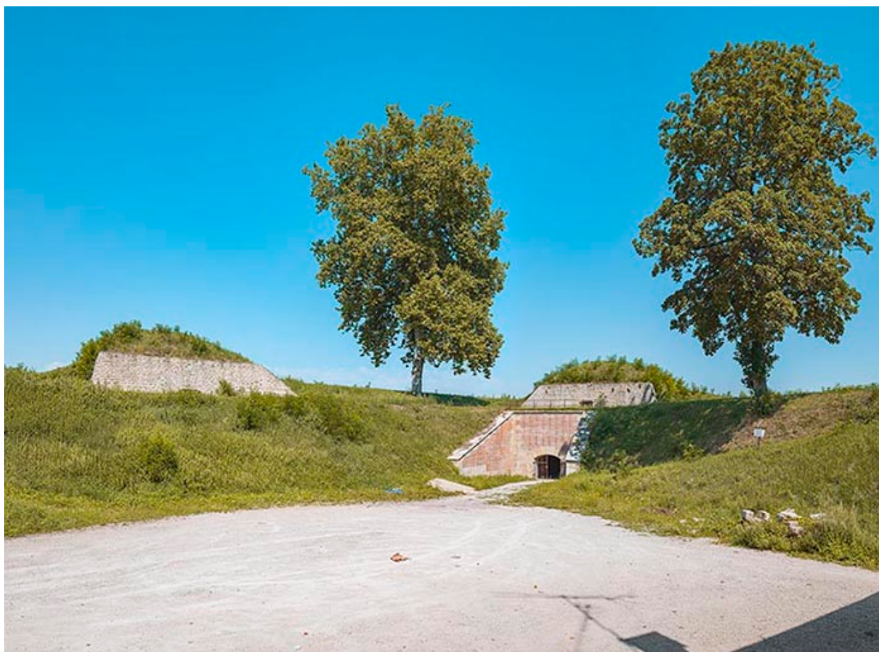
Vue générale du bastion depuis sa gorge.
