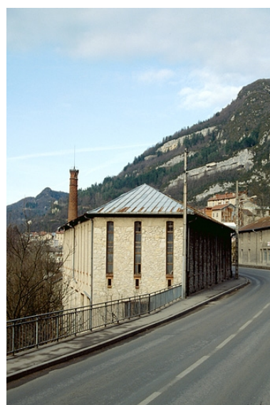
Façade latérale gauche du séchoir à ébauchons. Phot. Laurent Poupard IVR43_19923901447ZA
