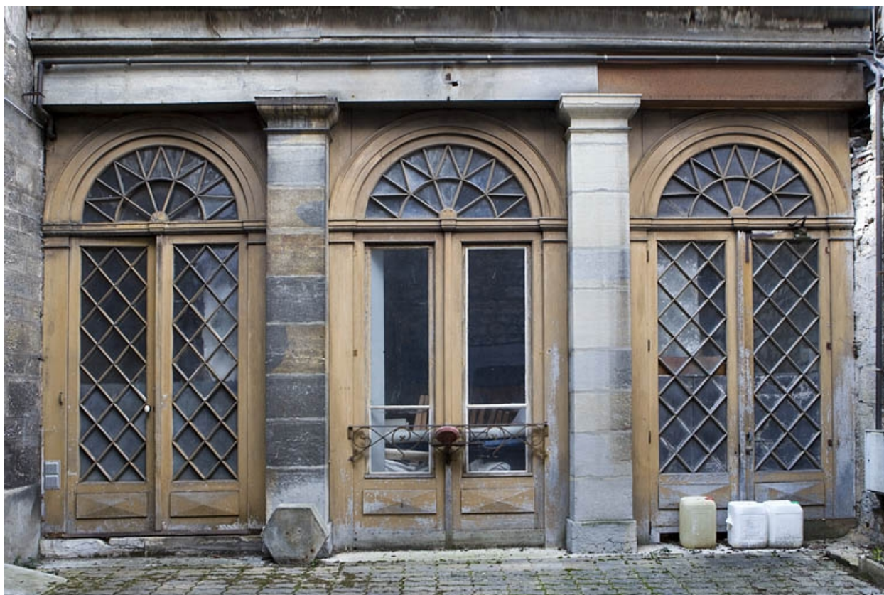
Détail du rez-de-chaussée de l'aile droite.
