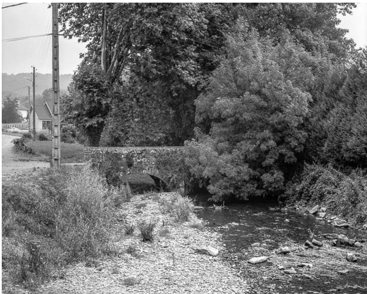
Pont sur la Sorne situé rue du Goujon.
