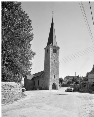
Eglise paroissiale Saint-Roch. Phot. Yves Sancey IVR43_19843900037V
