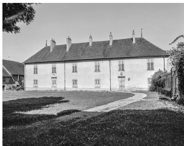
Château situé rue de la Cascade. Phot. Yves Sancey IVR43_19843900041X
