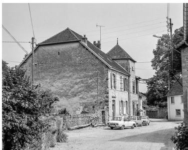
Maison située rue de la Cascade. Phot. Yves Sancey IVR43_19843900048X
