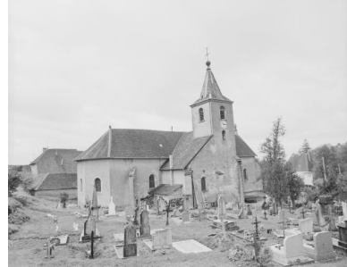
Façade latérale gauche. Phot. Yves Sancey IVR43_19753900625X
