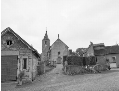
Façade antérieure depuis l'entrée du cimetière. Phot. Yves Sancey IVR43_19753900624X
