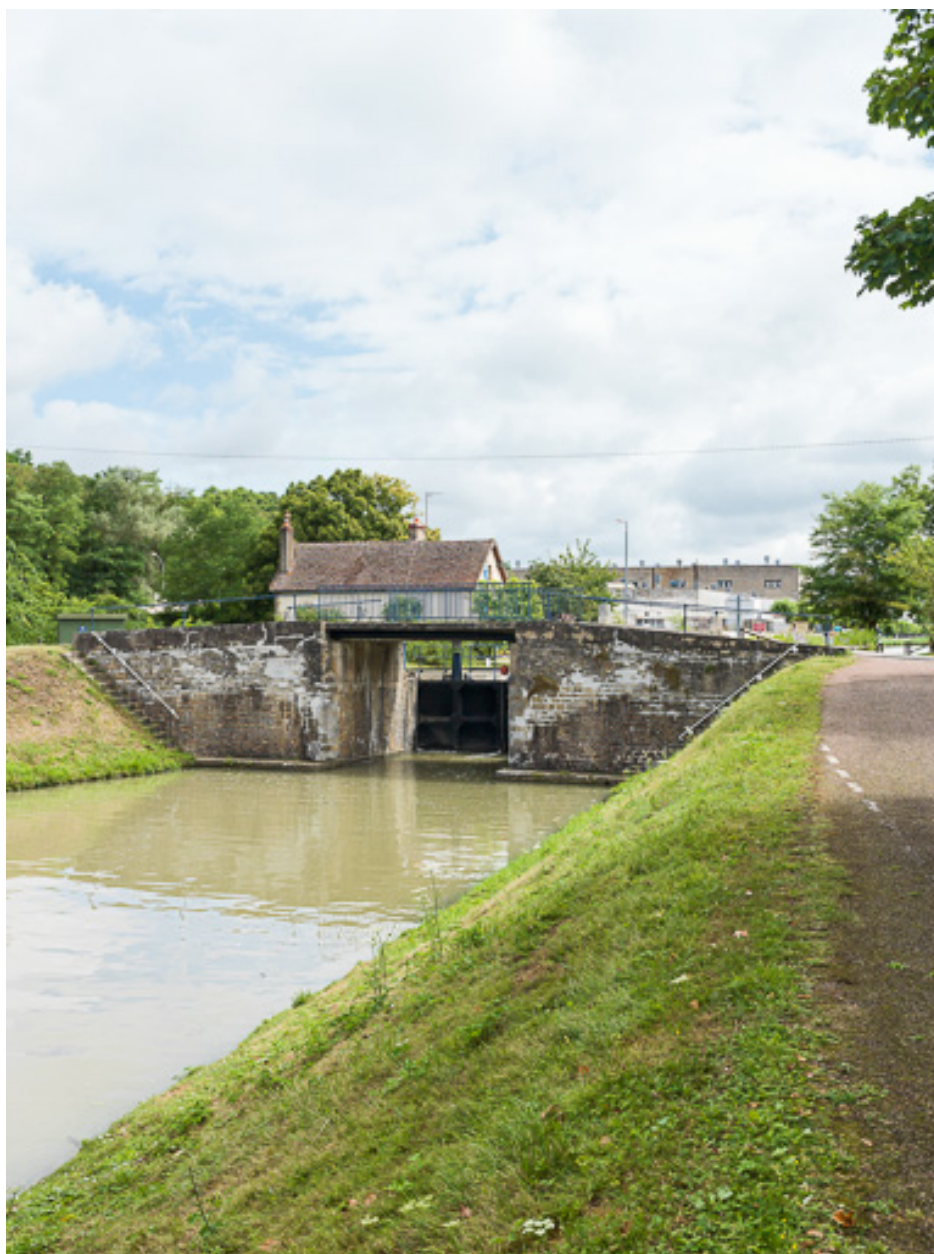
Vue d'ensemble du pont.
