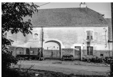
Façade antérieure vue de face. Phot. Bernard Pontefract IVR43_19753901000Z
