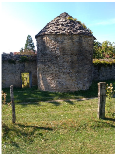
Vue de la tour depuis le nord-est, avant restauration. Phot. Baptiste Quost IVR26_20242100034NUC2A
