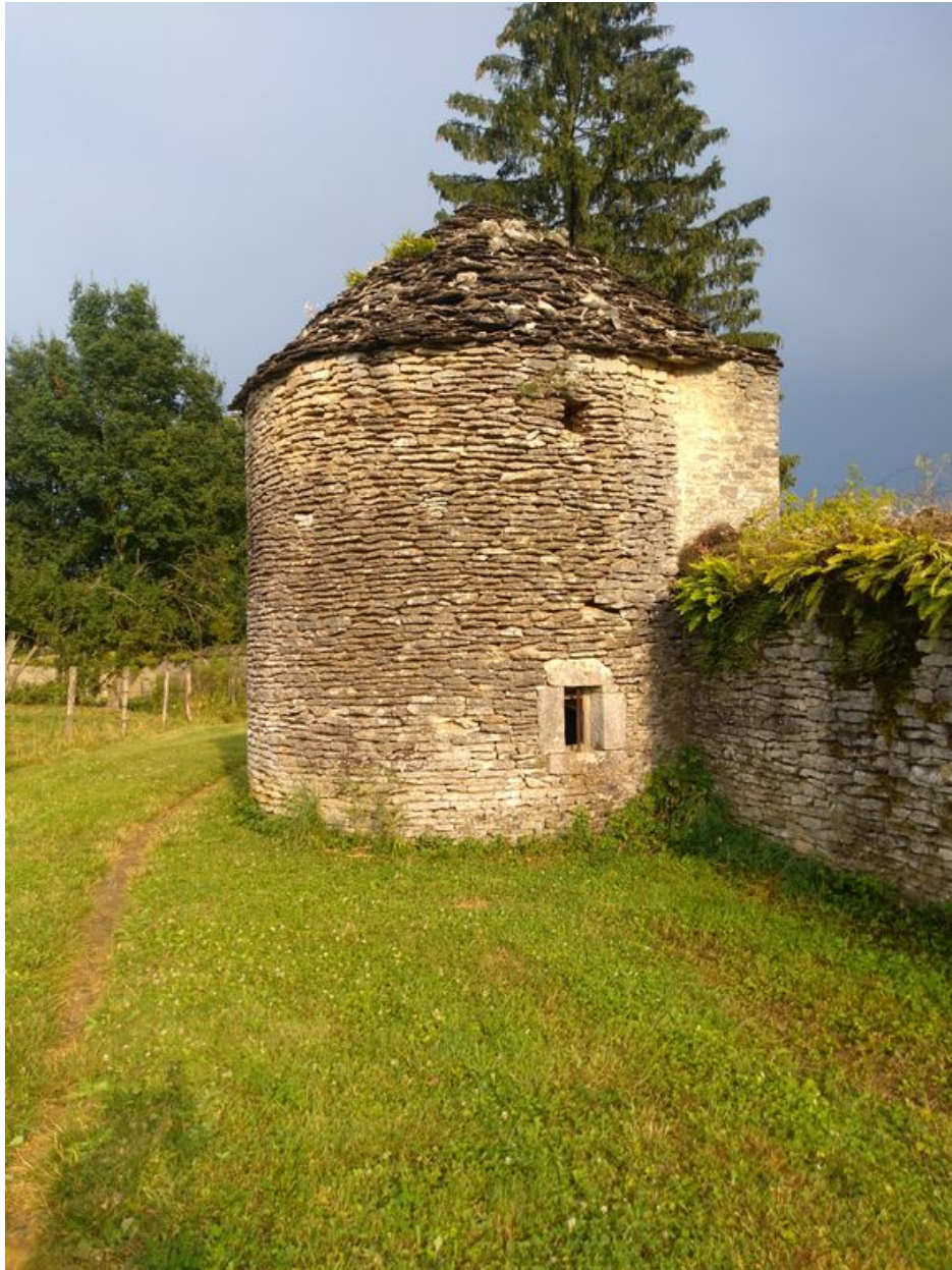
Vue de la tour depuis l'ouest, avant restauration.
