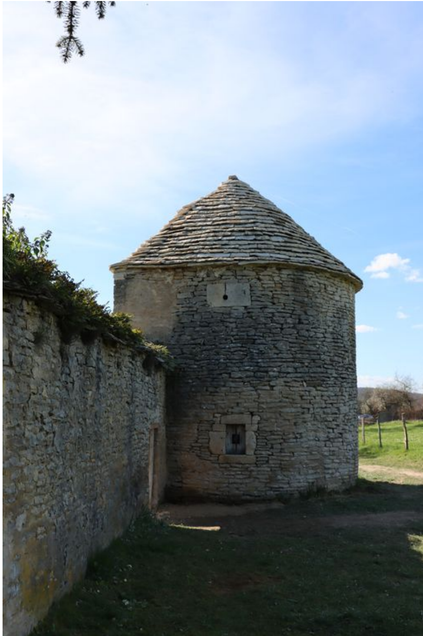
Vue de la tour depuis l'est, après restauration de la toiture en laves.
