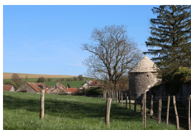
Vue de la tour depuis l'est, après restauration de la toiture en laves. Phot. Baptiste Quost IVR26_20242100036NUC2A
