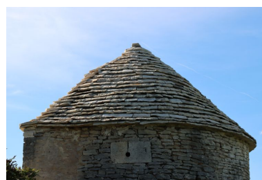
Détail de la toiture en lave et de l'ouverture de tir. Phot. Baptiste Quost IVR26_20242100056NUC2A
