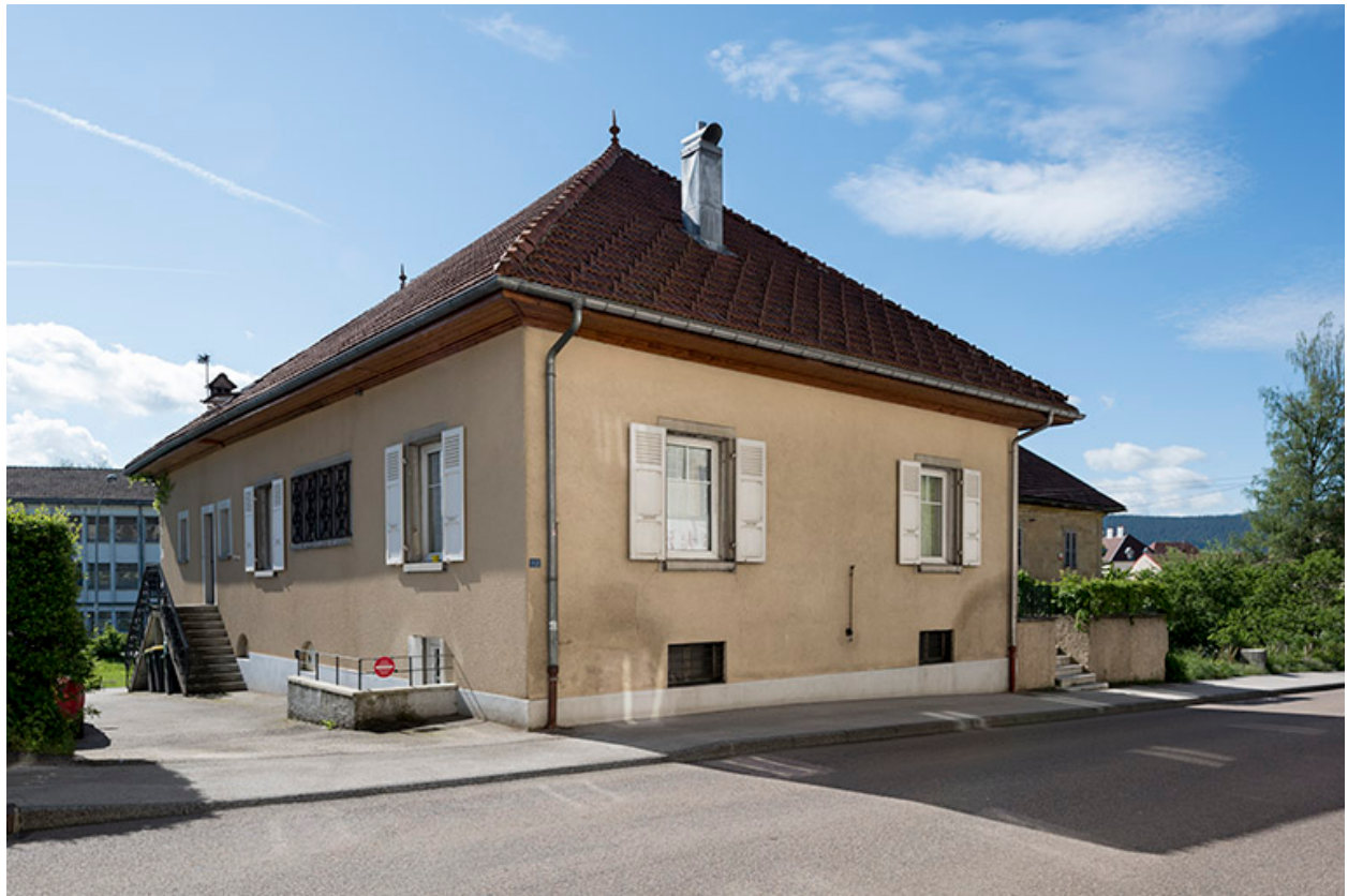
Corps nord : façades antérieure et latérale gauche.
