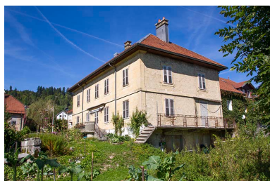
Corps sud : façades postérieure et latérale droite. Phot. Yves Sancey IVR43_20132502293NUC2A
