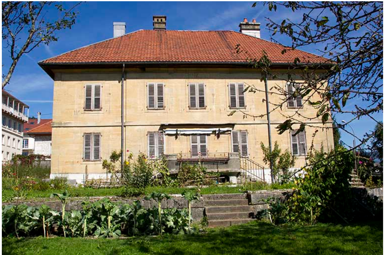
Corps sud : façade latérale droite.
