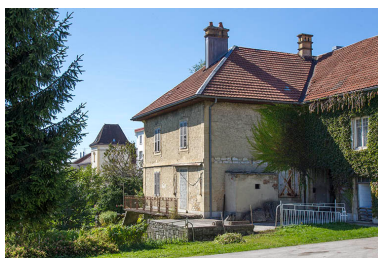
Corps sud : façades postérieure et latérale gauche. Phot. Yves Sancey IVR43_20132502292NUC2A
