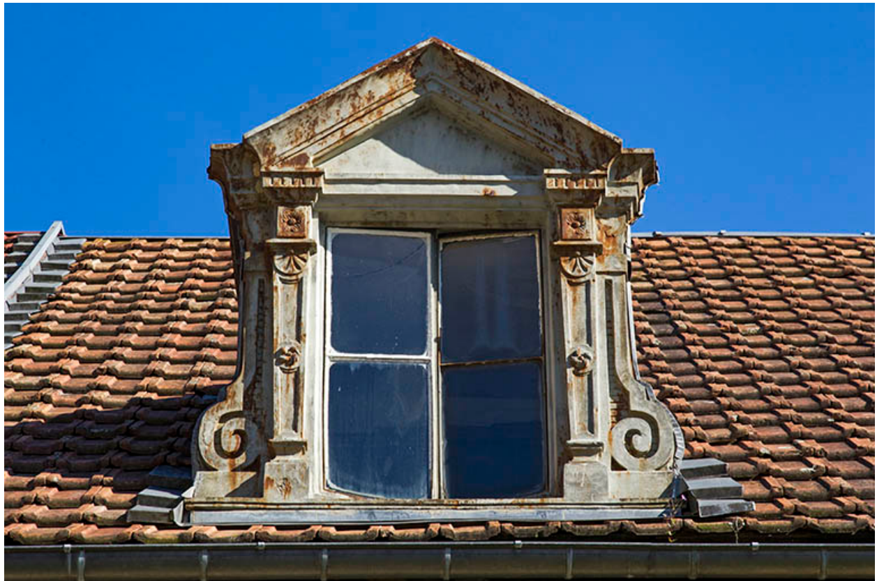
Corps sud, façade antérieure : lucarne.
