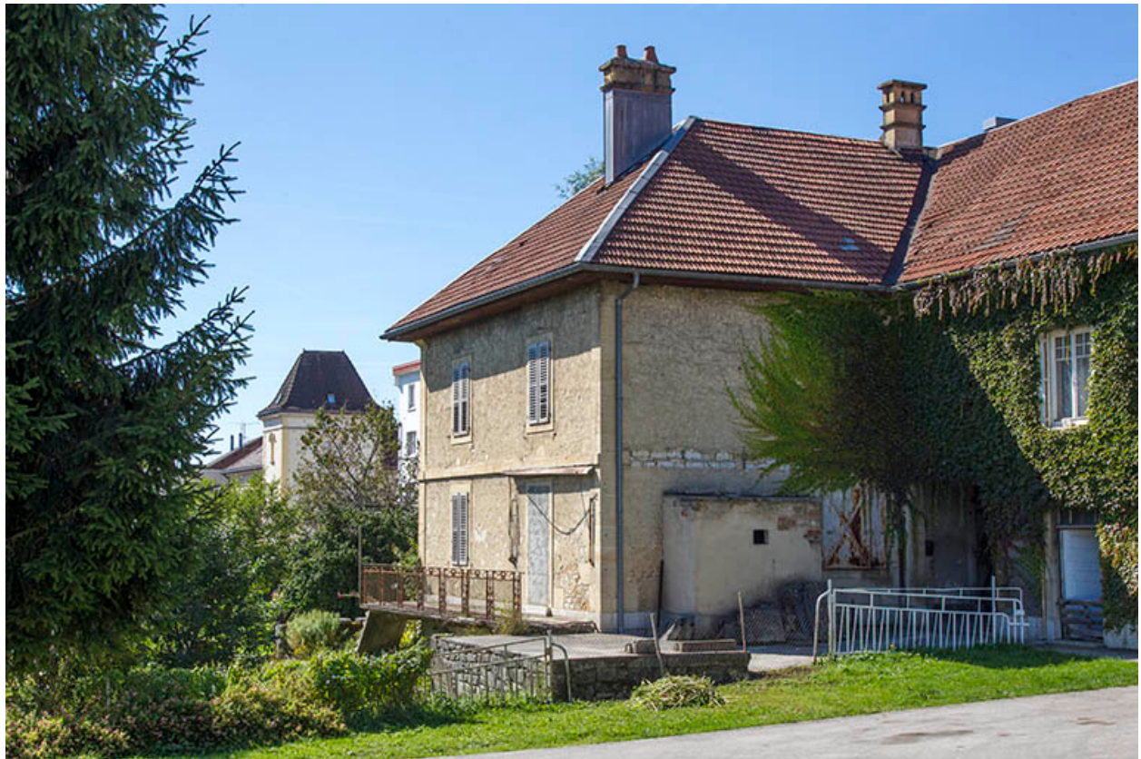
Corps sud : façades postérieure et latérale gauche.
