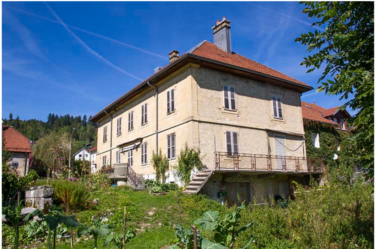
Corps sud : façades postérieure et latérale droite.
