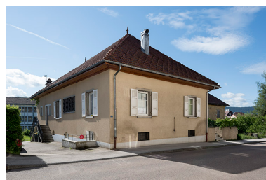
Corps nord : façades antérieure et latérale gauche. Phot. Sonia Dourlot IVR43_20182500956NUC4A
