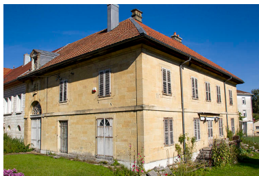
Corps sud : façades antérieure et latérale droite. Phot. Yves Sancey IVR43_20132502296NUC2A
