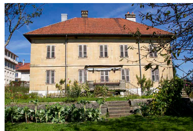
Corps sud : façade latérale droite. Phot. Yves Sancey IVR43_20132502294NUC2A
