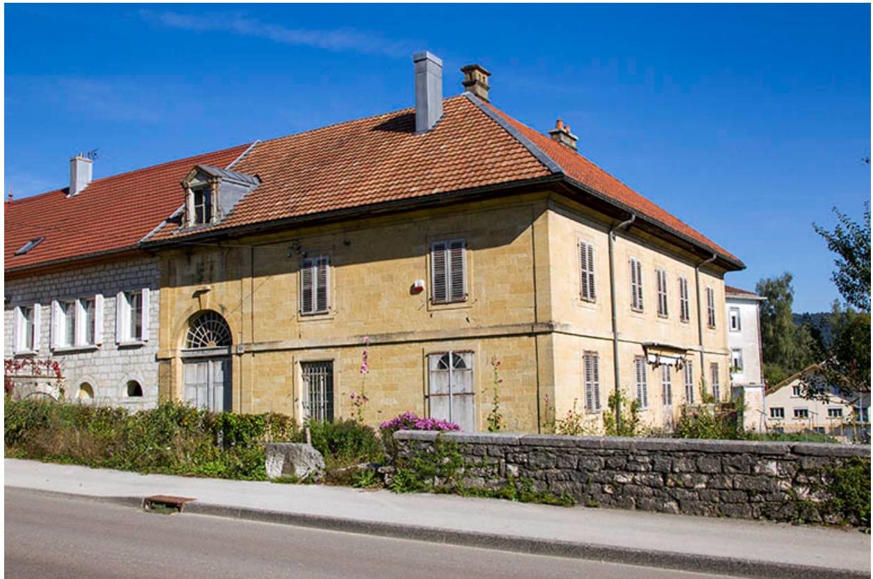
Corps sud : vue d'ensemble, depuis le sud-ouest.
