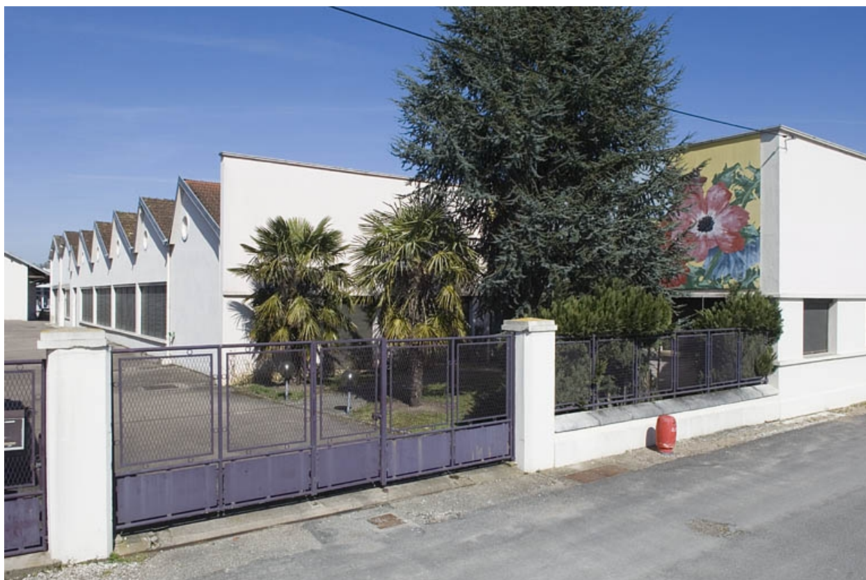
Vue de l'atelier depuis l'ancienne entrée.
