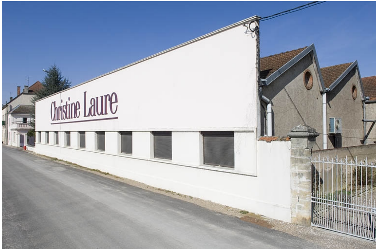
Façade sud de l'atelier de fabrication.
