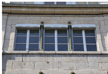
Immeuble 1 rue Prodouhon. Détail d'une baie horlogère (1er étage). Phot. Yves Sancey IVR43_20122500461NUC2A
