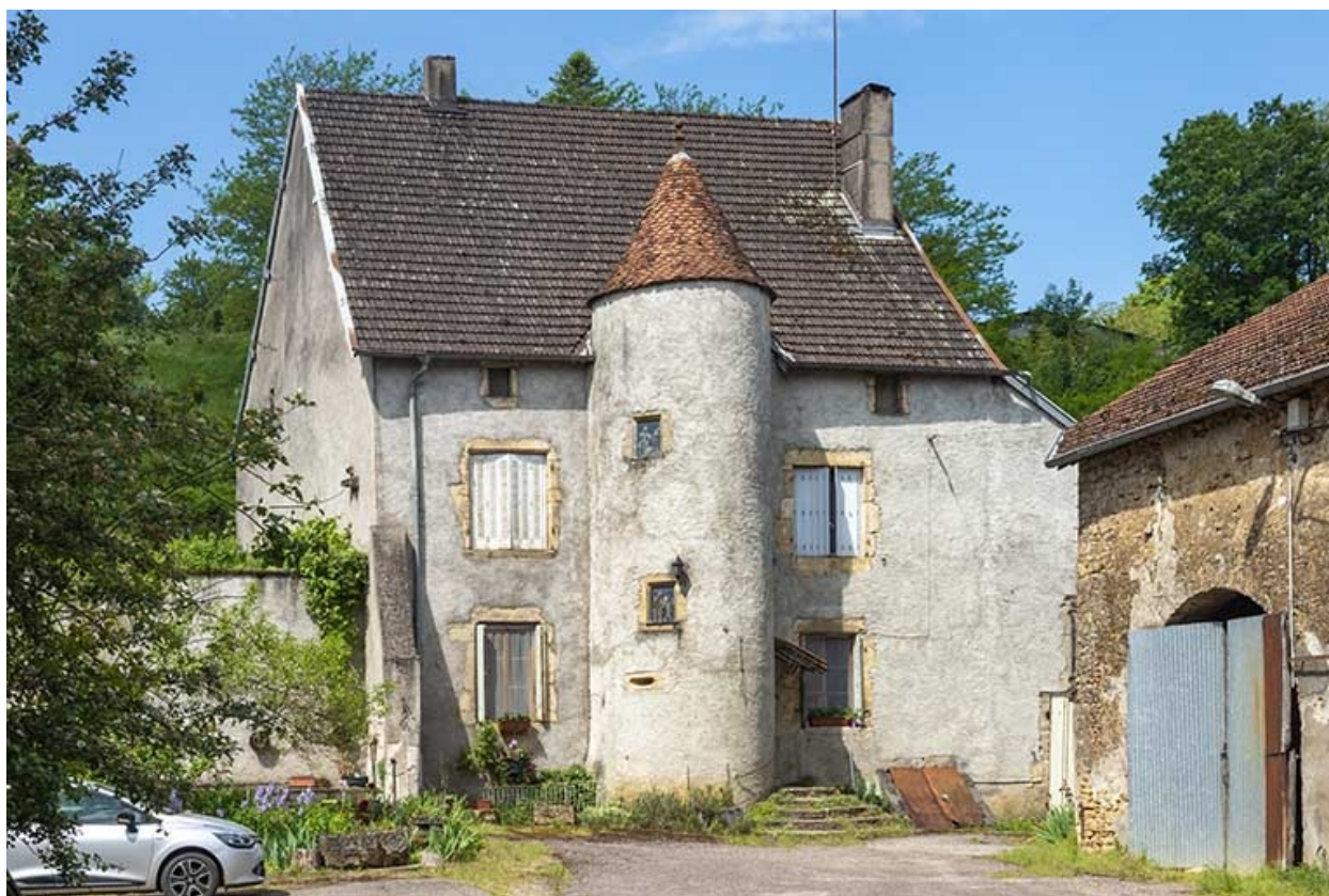
La façade antérieure depuis la rue.
