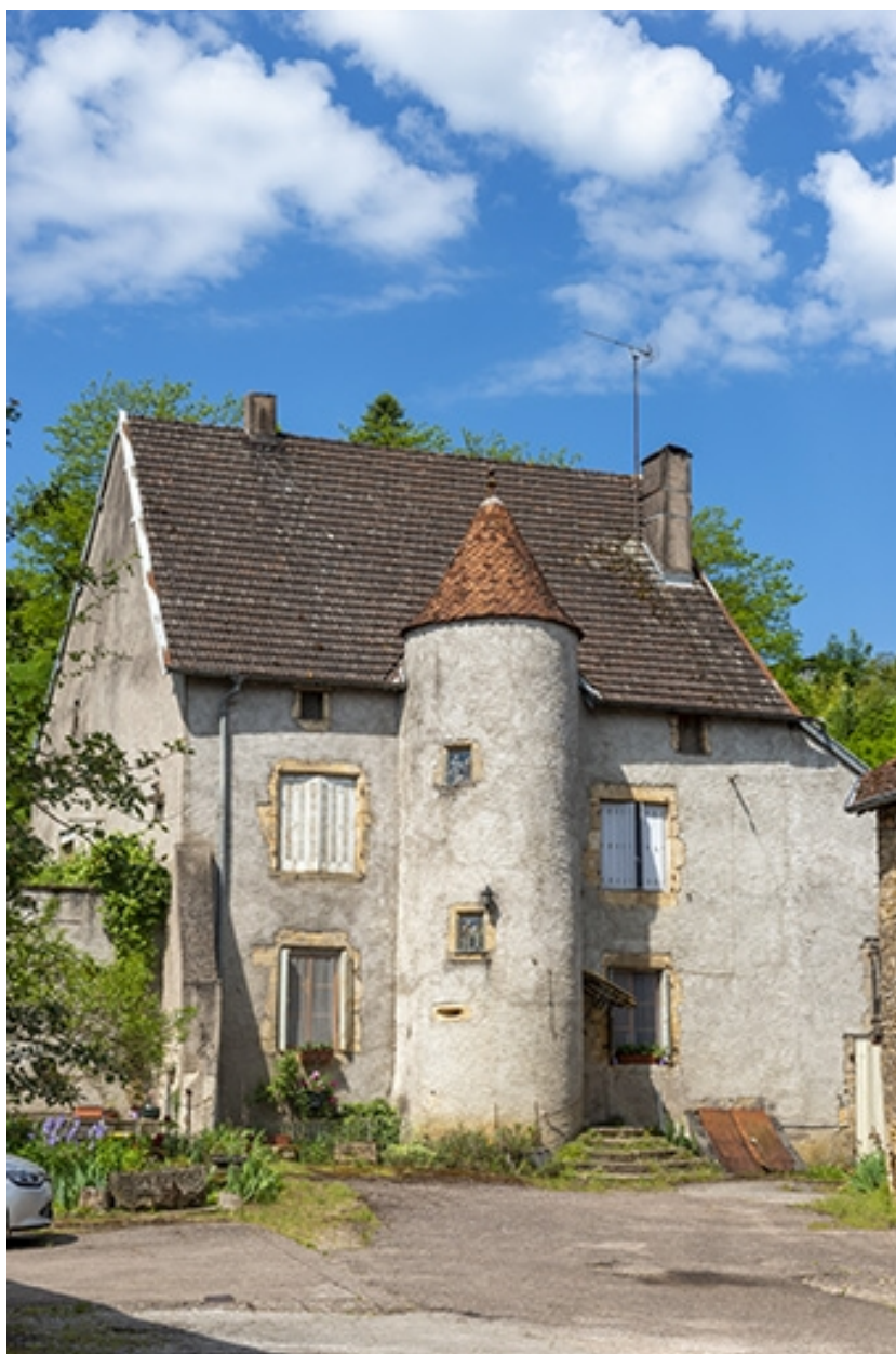
La façade antérieure depuis la rue.
