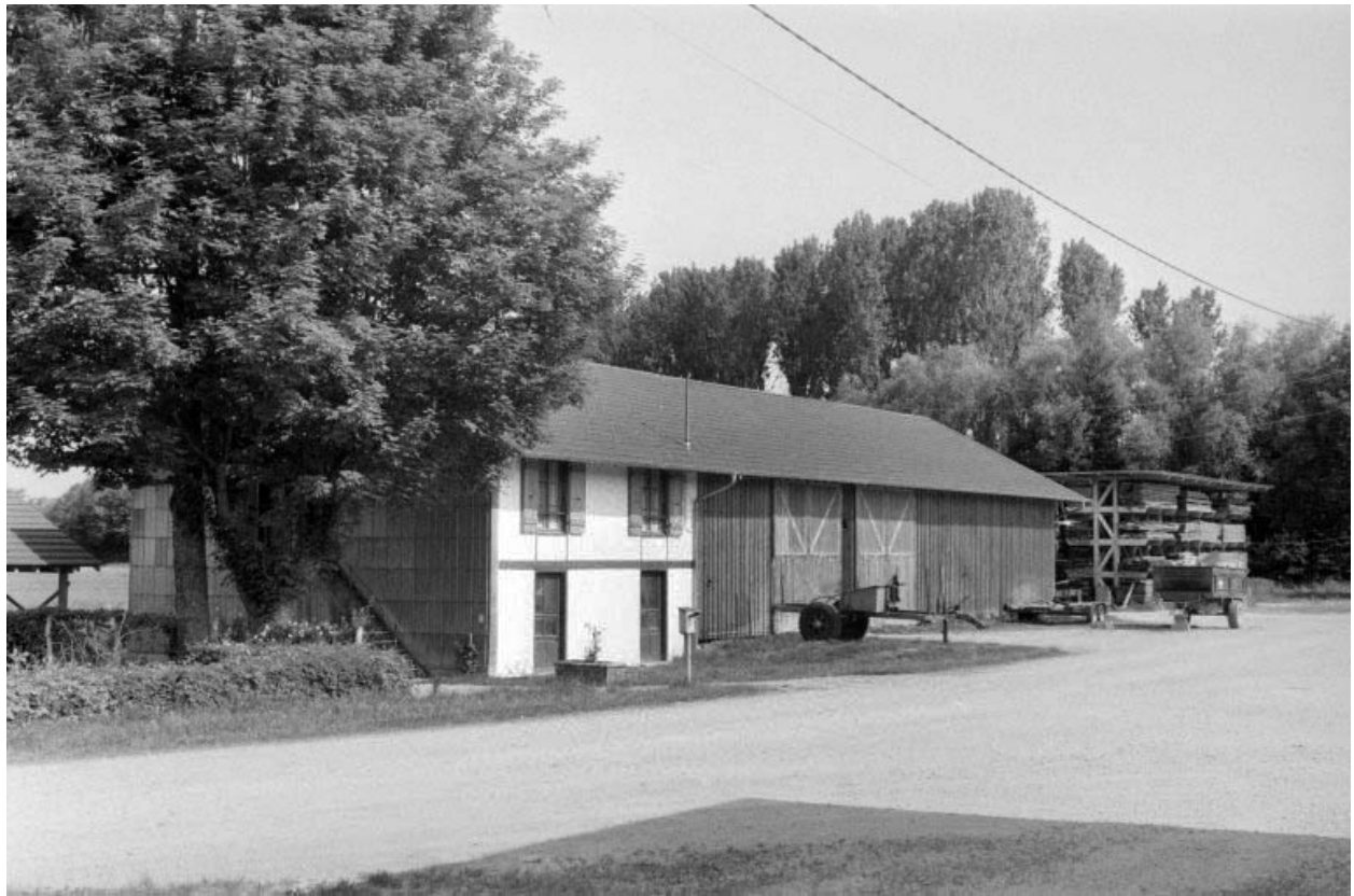
Magasin industriel (M) et logement d'ouvriers (N).
