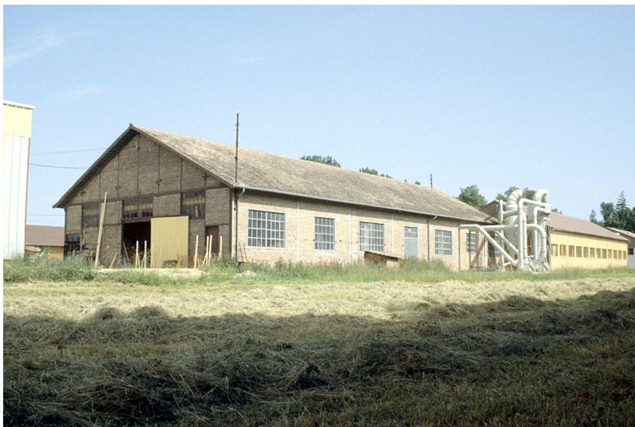
Atelier de fabrication (K), depuis le sud.
