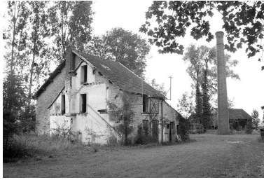
Ecuries (G) et cheminée d'usine (F). Phot. Laurent Poupard IVR43_19883900508Z
