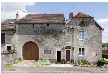
Façade antérieure. Phot. Jérôme Mongreville IVR43_20127000100NUC4A
