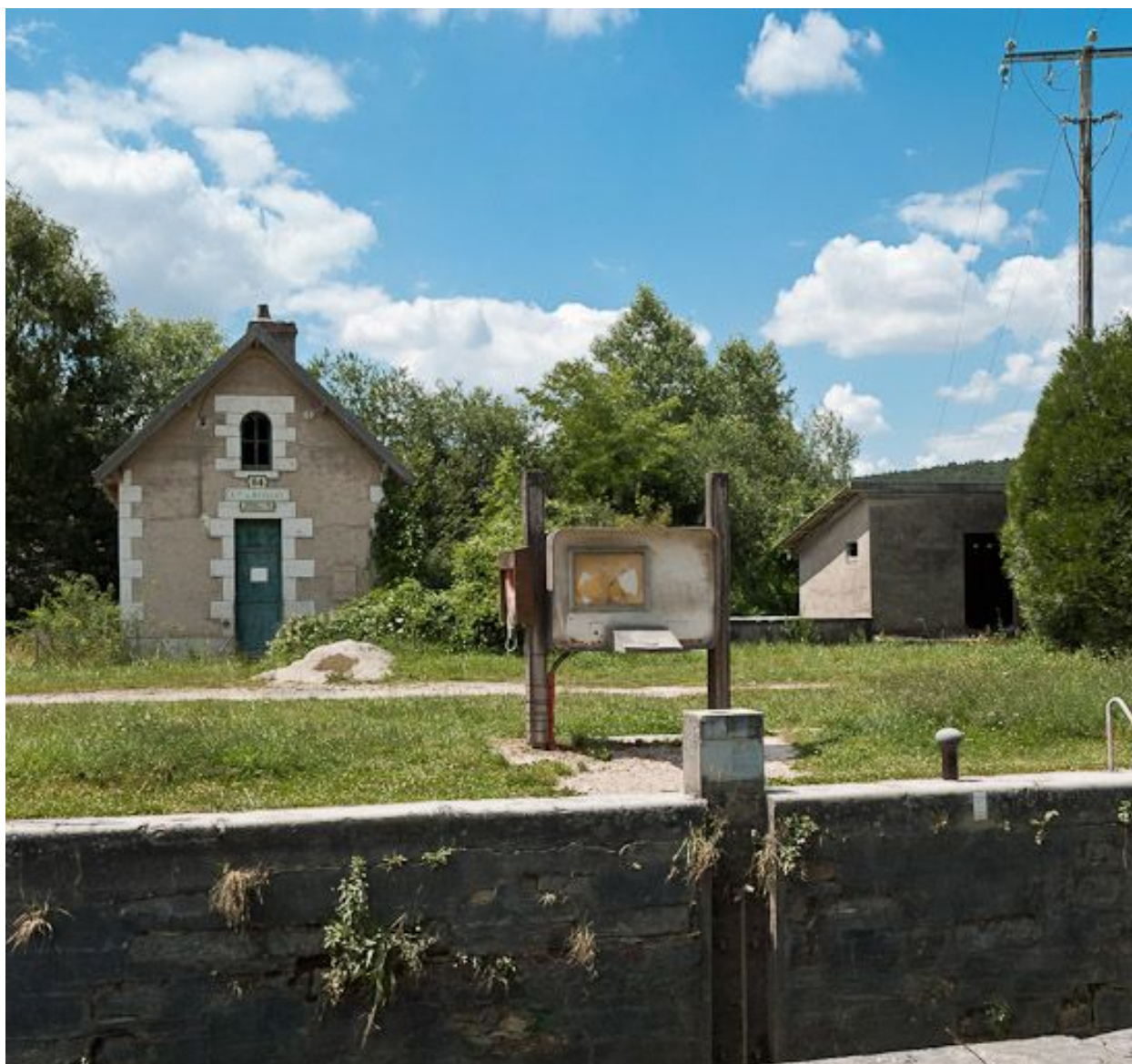
Vue d'ensemble du site d'écluse.
