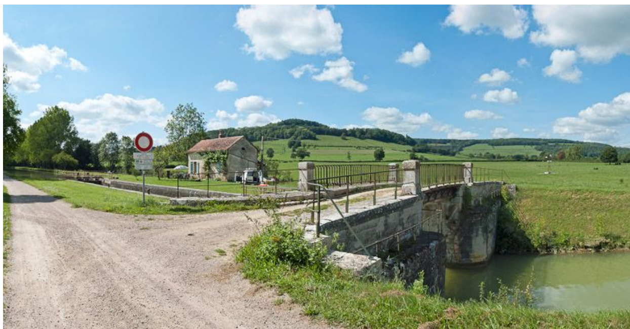
Vue d'ensemble du site d'écluse.
