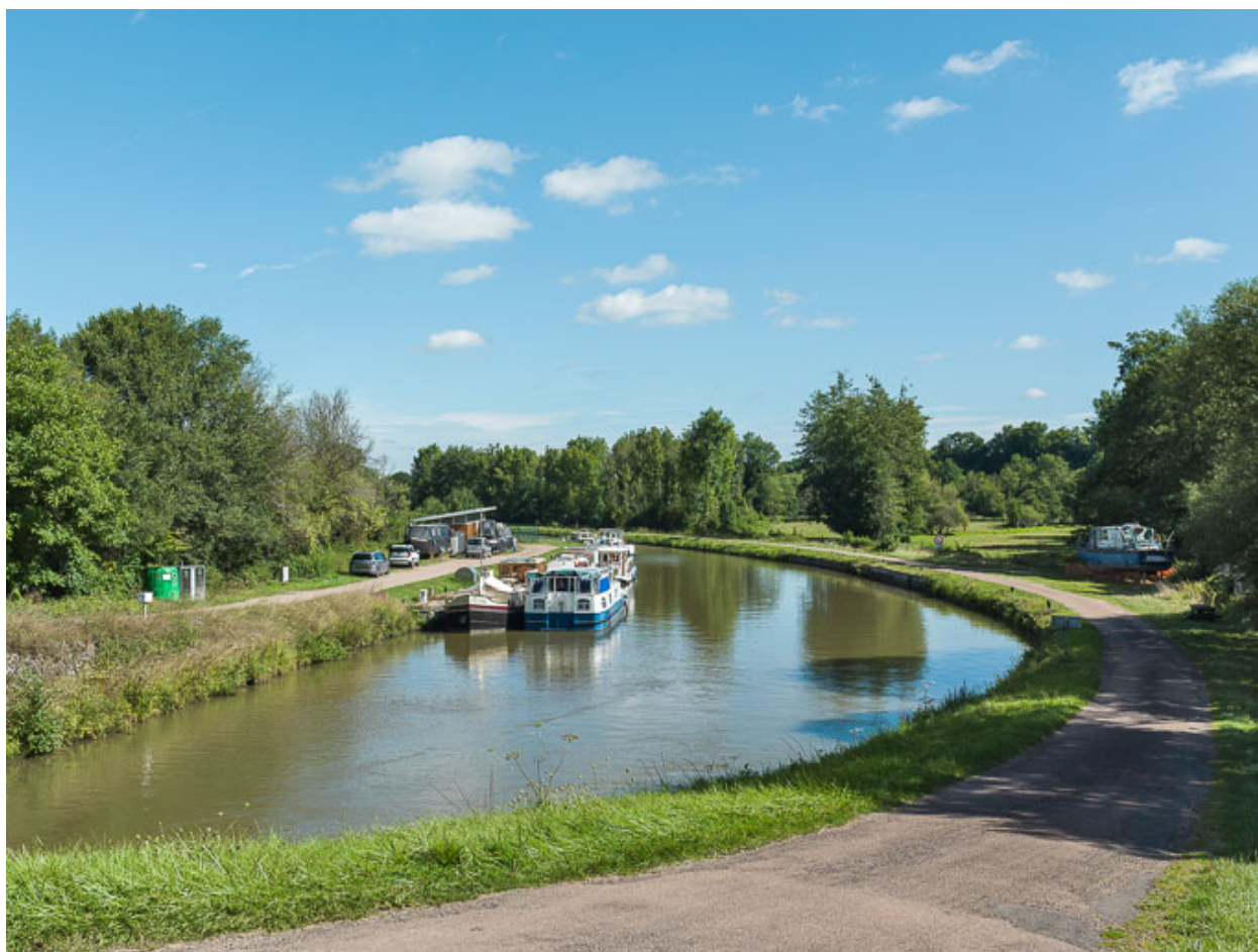
Vue d'ensemble du port.
